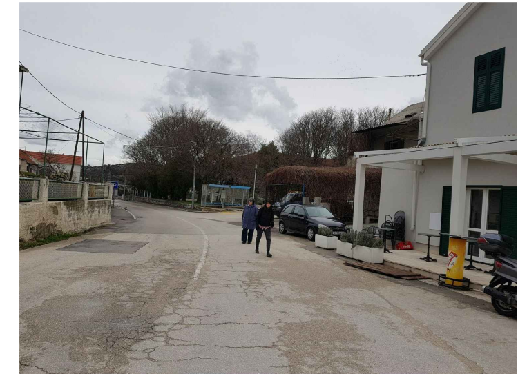
slika br. 71 - fotografija postojećeg stanja
