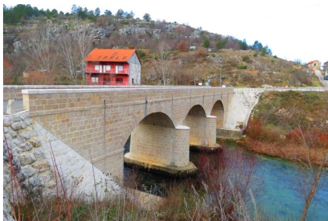
Fotografija 4.4. Povijesni cestovni mostovi na području SDŽ-a; odozgo prema dolje, po redovima: Pavića most (Podgrađe) (Radnić i Smilović, 2008), Most na Panju (Rumin), Balečki most (Vinalić)
