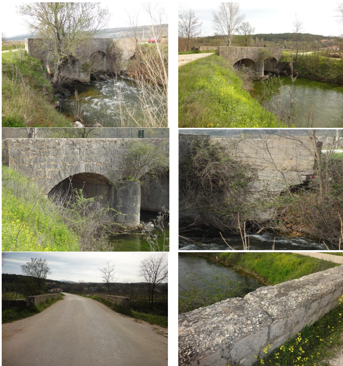
Fotografija 4.5. Most na Jarugi/Siji kod Mračaja u Imotskom polju (slike odzgo redom: prikaz mosta s istočne strane, prikaz mosta sa zapadne strane, krilo upornjaka, stup, pristupna cesta, ograda)
