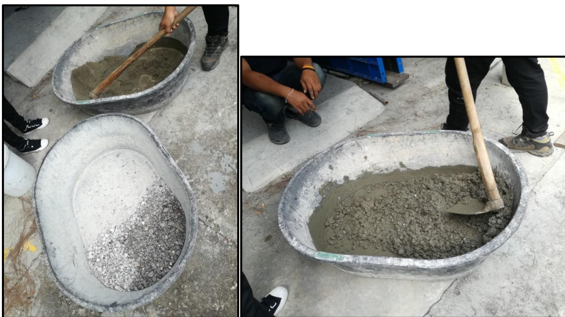
Slike 52. Priprema mješavine za beton
