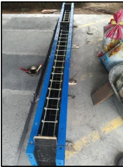
Slika 63. Kalup grede
