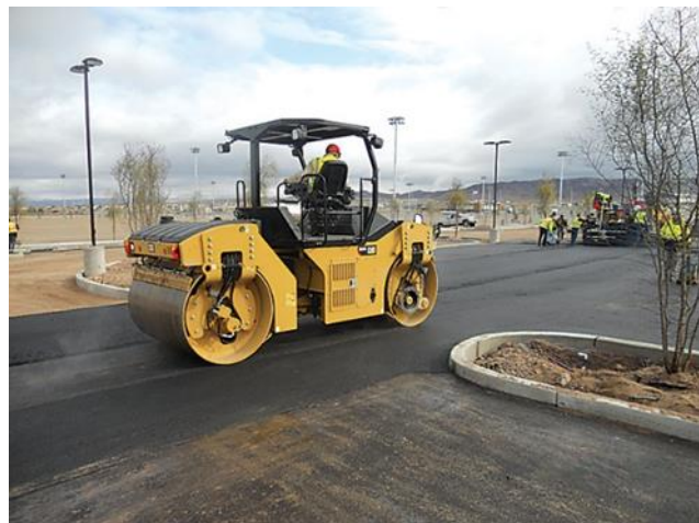
Slika 10. Valjak za zbijanje [11]
