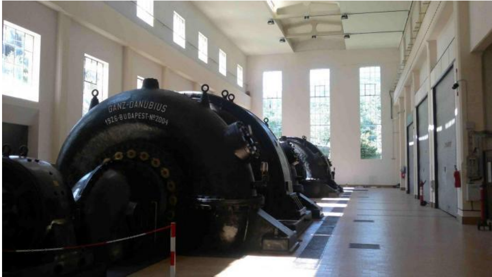
Slika 22. Horizontalni Francis-ov agregat
