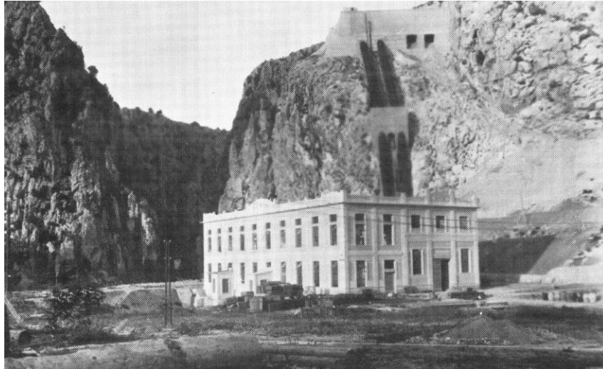
Slika 17. Završeni radovi prve faze izgradnje
