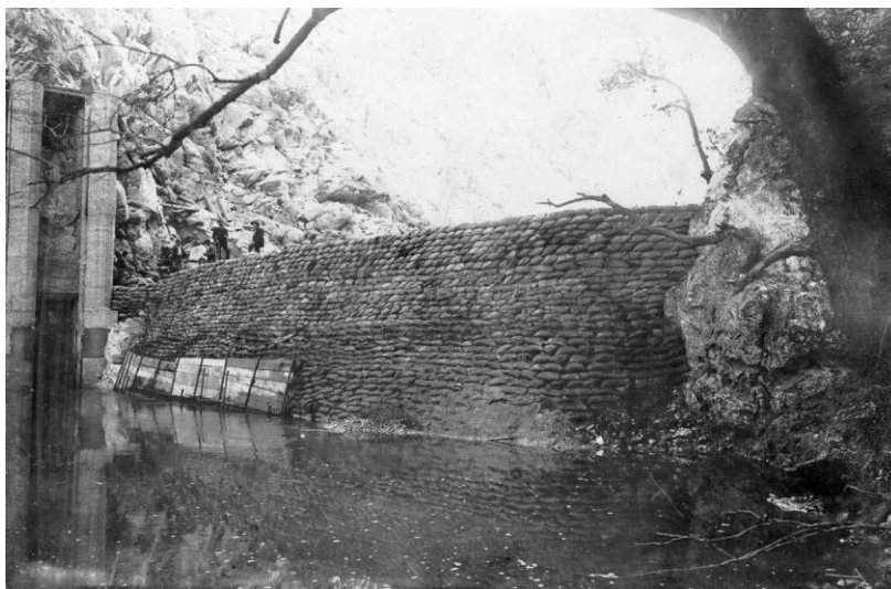
Slika 13. Provizorna brana i dio obilaznog tunela
