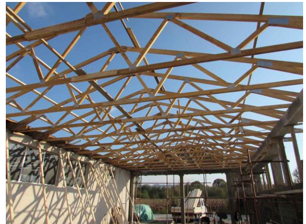
Slika 1.1.4. drveni rešetkasti nosači
