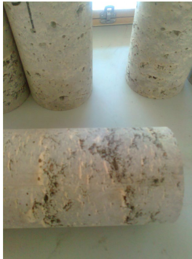
Slika 5.6. Segregacija betona prilikom ugradnje [slike iz laboratorija]
