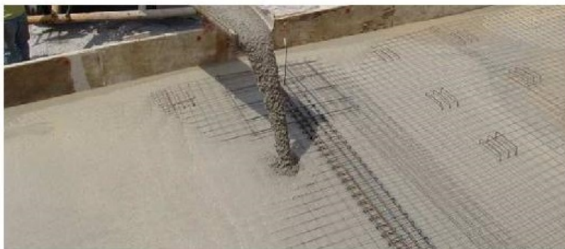
Slika 2.3. Samozbijajući beton tokom ugradnje [9]
