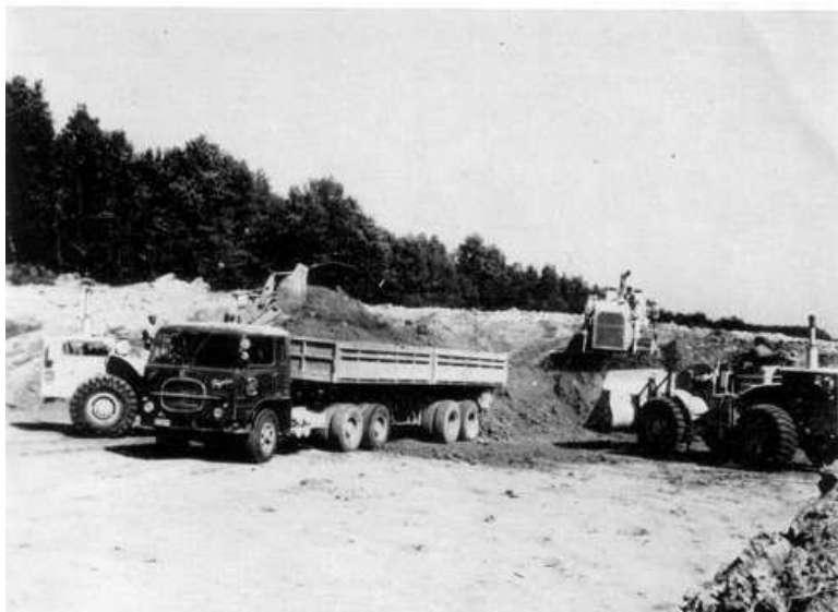
Slika 1.7 Iskop tla na pozajmištu za autocestu Zagreb-Karlovac (Celmić, 1974.)
