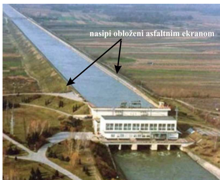
Slika 9.8 Dovodni kanal HE Varaždin, obložen asfaltnim ekranom
