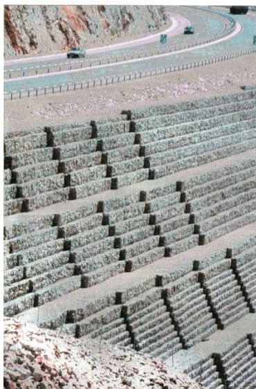
Slika 6.35 Visoki kameni nasip obložen gabionima na autocesti A1 kod tunela Sveti Rok
