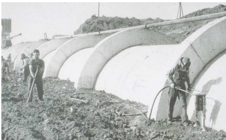
Slika 8.33 Ugradnja cijevi i spojnica (FEMA 484, 2005.)
