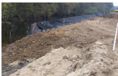
Slika 6.29 Ugradnja čeličnog (Larsen) žmurja i geotekstila pri sanaciji nasipa u Istočnoj Slavoniji 2014.
