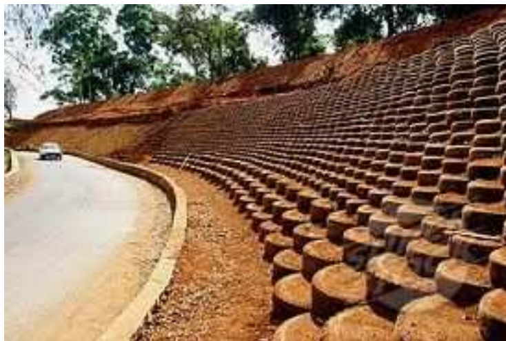
Slika 9.6 Nasip dijelom izveden od iskorištenih automobilskih guma
