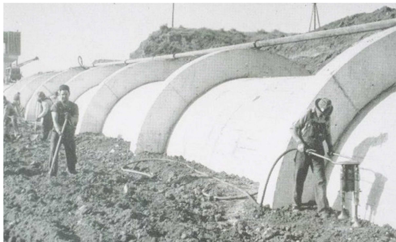
Slika 8.33 Ugradnja cijevi i spojnica (FEMA 484, 2005.)
