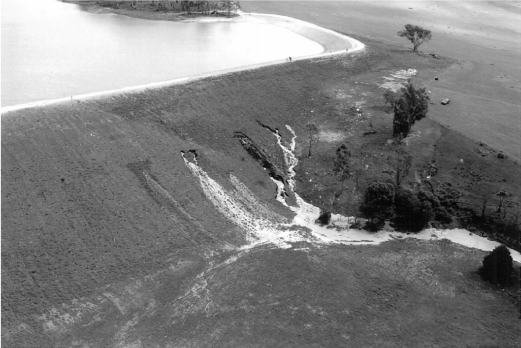
Slika 8.27 Koncentrirani tok na nizvodnoj strani nasipa Tunbridge, (Fell i dr. 2015.) uslijed procjeđivanja kroz slabije zbijeni sloj
