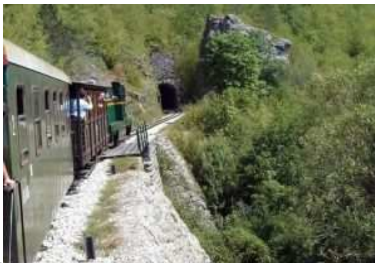
Slika 6.33 Strmi kameni željeznički nasip, u pozadini kameni potporni zid http://ivanica.freshcreator.com/
