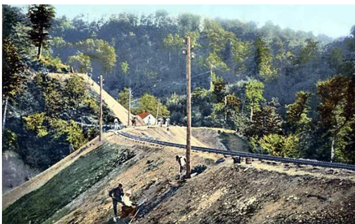
Slika 6.32 Željeznički, zemljani nasip trapeznog presjeka www.zeljeznice.net
