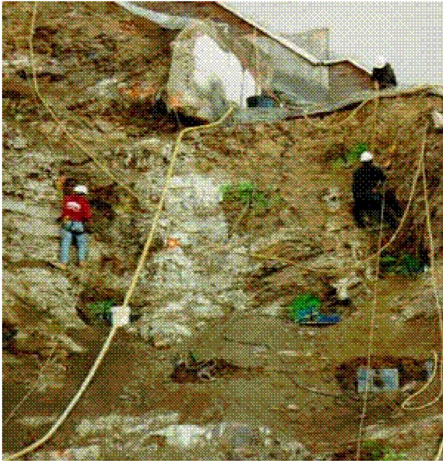
Slika 7.25 Potporna sidrena građevina (u izvedbi), poduprta isključivo sidrima
