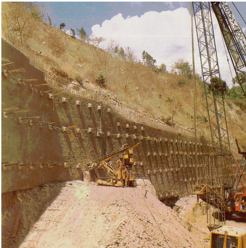
Slika 7.1 Sidrena građevina s armirano betonskom pločom na površini pokosa
