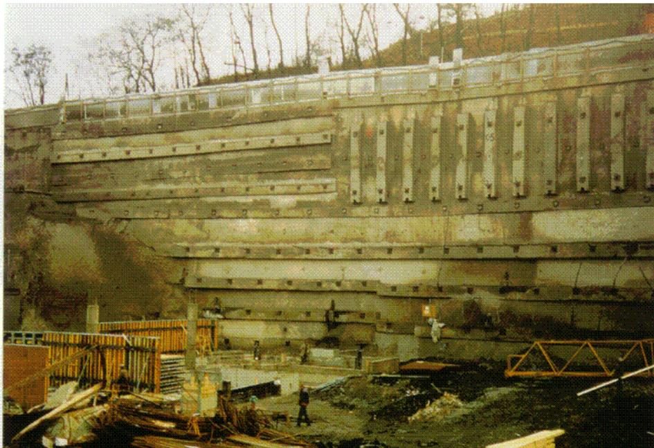
Slika 8.27 Nosači za prijenos sila s dijafragme na geotehnička sidra (Zakladani staveb, 1999.) .
