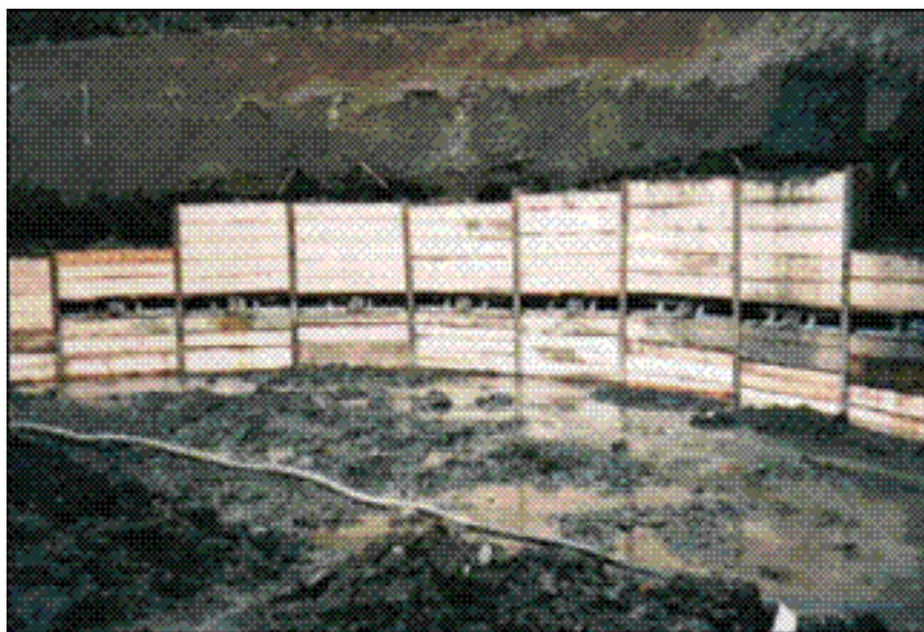
Slika 8.25 Berlinsko ziđe u dnu građevne jame
