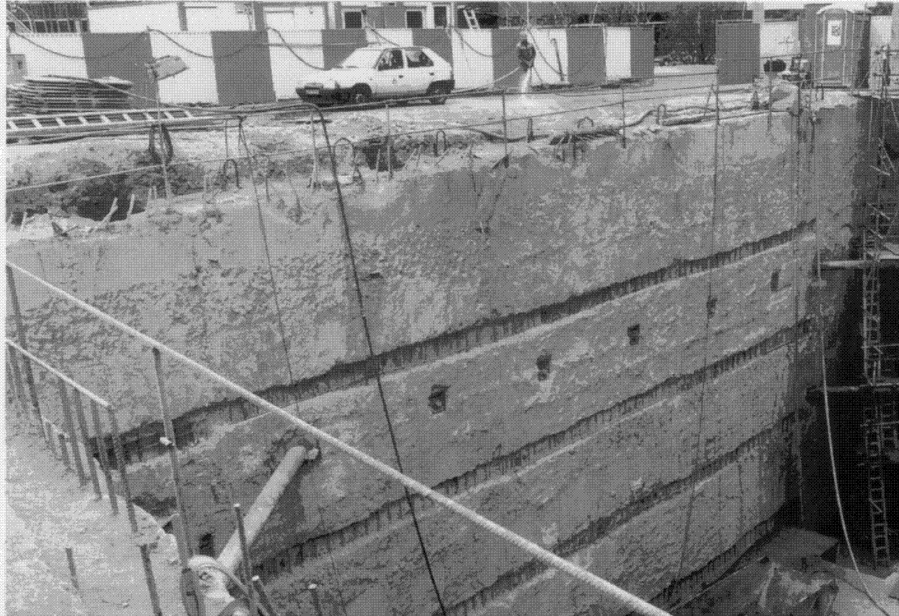
Slika 8.3 Građevna jama zaštićena armirano–betonskom dijafragmom (Jakl, 1999.)
