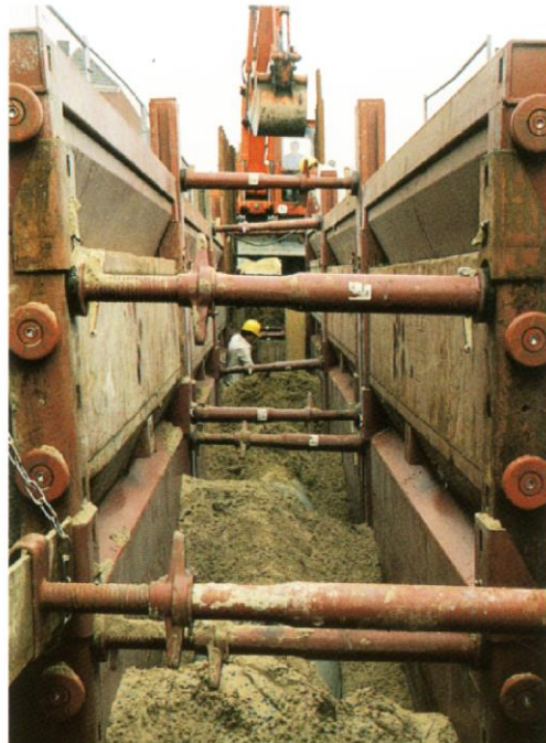
Slika 8.20 Sustav oplata s pločama i vodilicama
