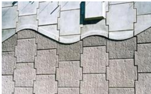
Slika 4.15 Lice od betonskih, križnih elemenata gledano srijeda
