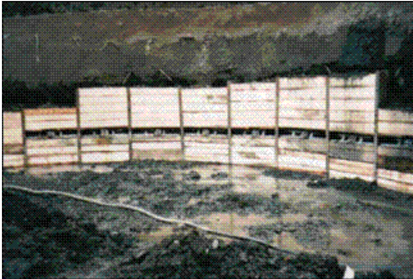
Slika 8.25 Berlinsko zide u dnu građevne jame
