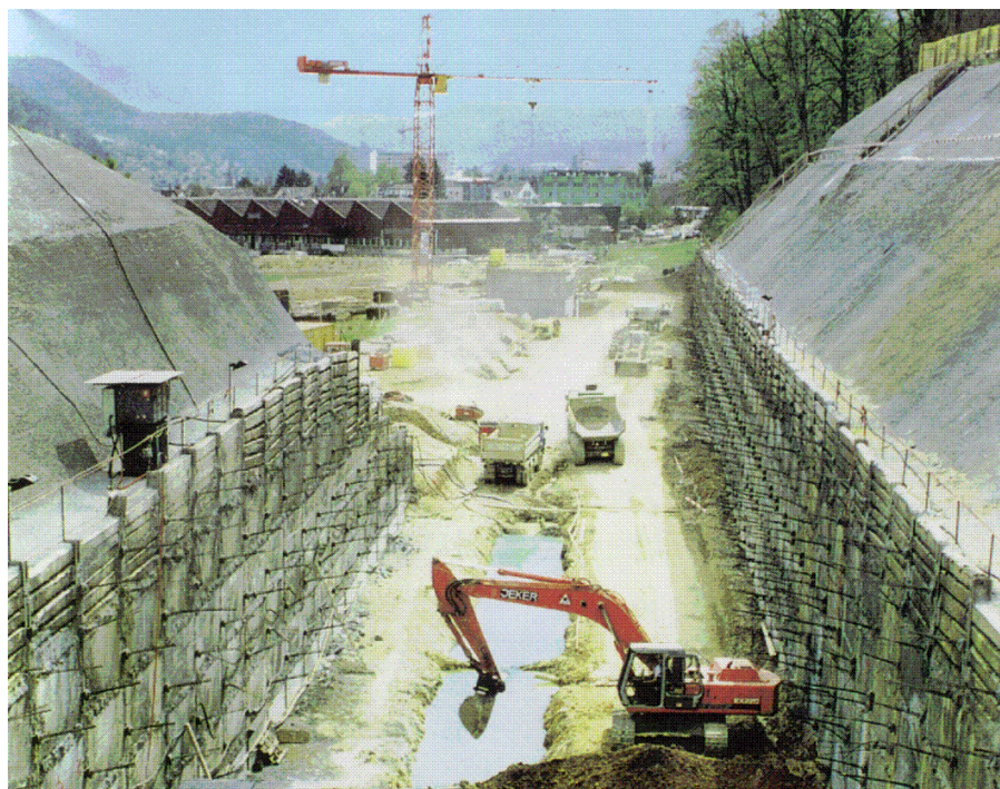
Slika 7.28 Složena sidrena građevina (BBR-CONEX, 1996.-1998.)
