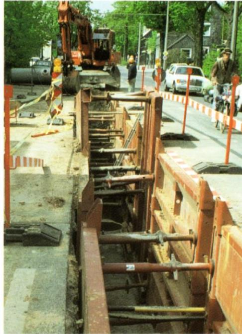
Slika 8.19 Sustav oplata za iskop kanala s pločama
