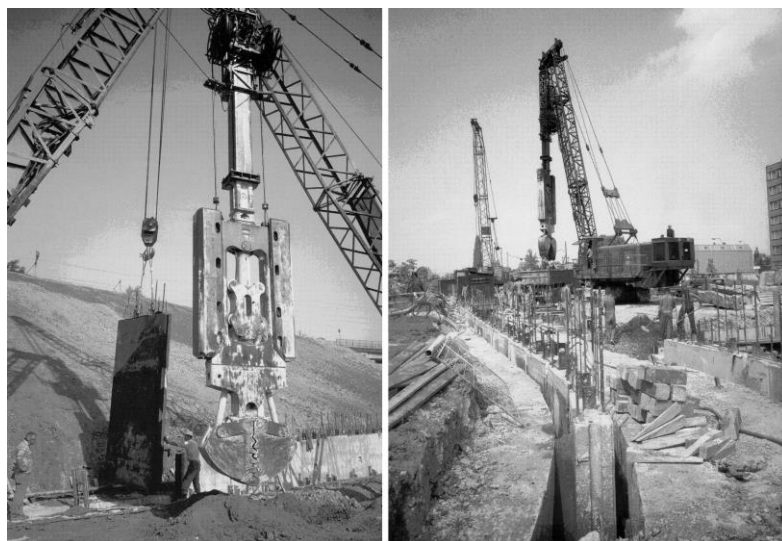
element pri ugradnji i grabilica
