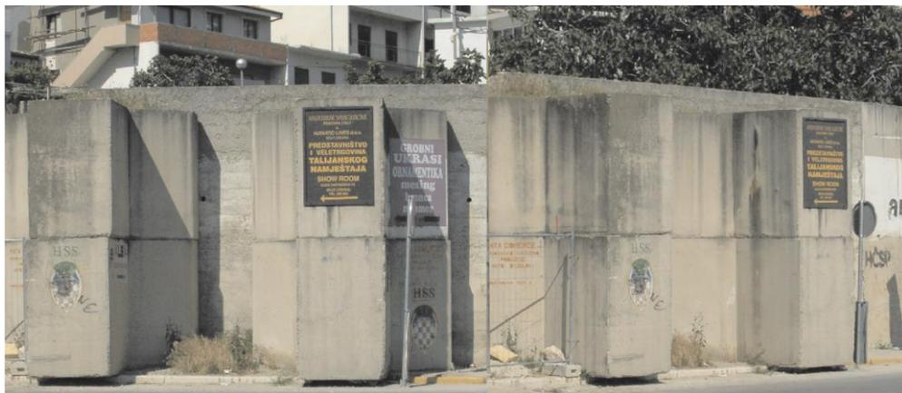
Slika 3.9 Betonski blokovi kao podupore nestabilnom konzolnom zidu (dokumentacija autora)
