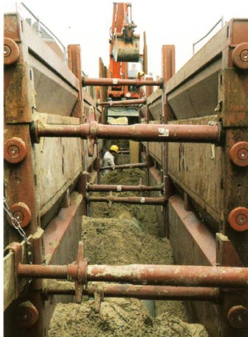
Slika 8.20 Sustav oplata s pločama i vodilicama
