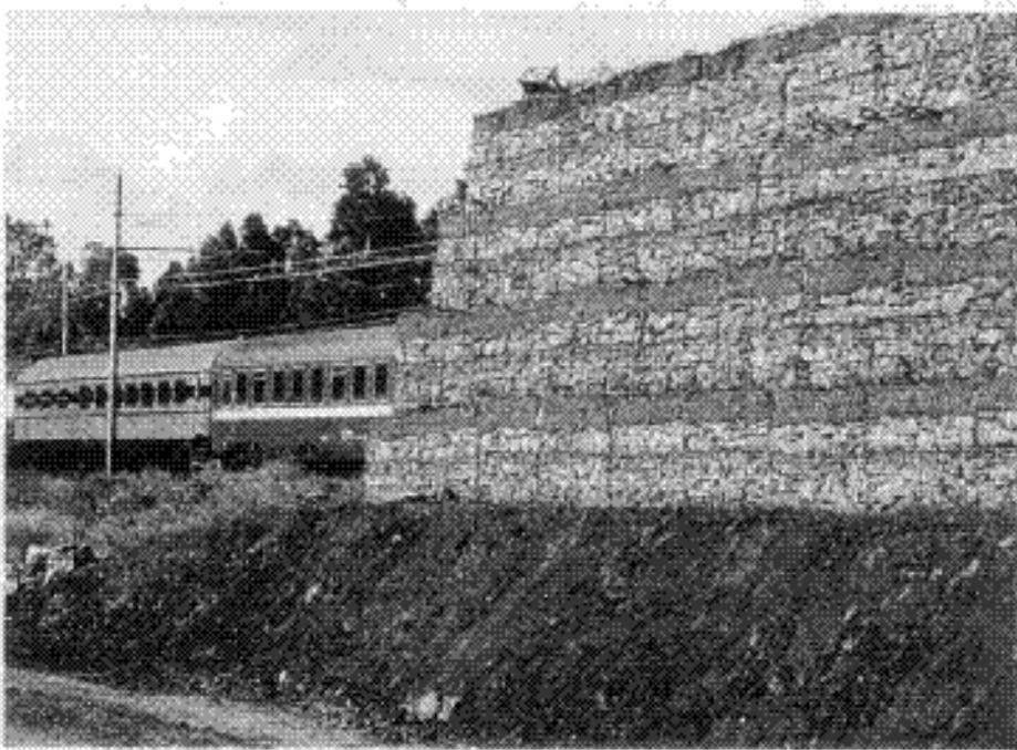
Slika 3.36 Gabionski zid za zaštitu od buke (Maccaferri, 1997.)
