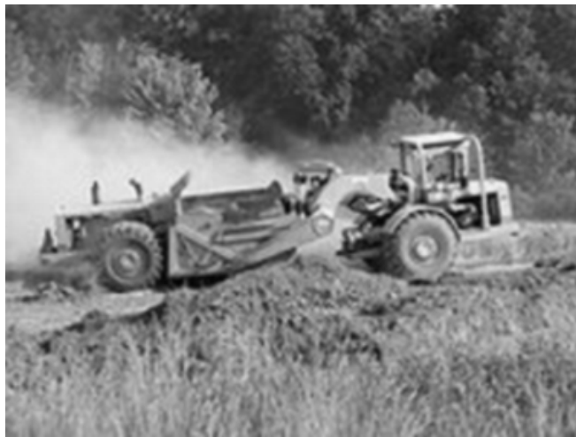
Slika 8.12 Skreper u radu pri iskopu i utovaru
