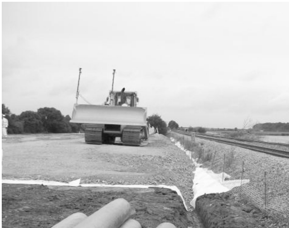
Slika 11.13 Nasip na geotekstilu
