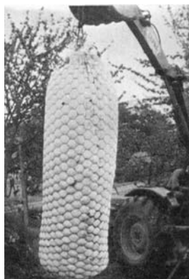
Slika 14.21 Tonjača (sa slike 14.19) od geosintetika, punjena šljunkom
