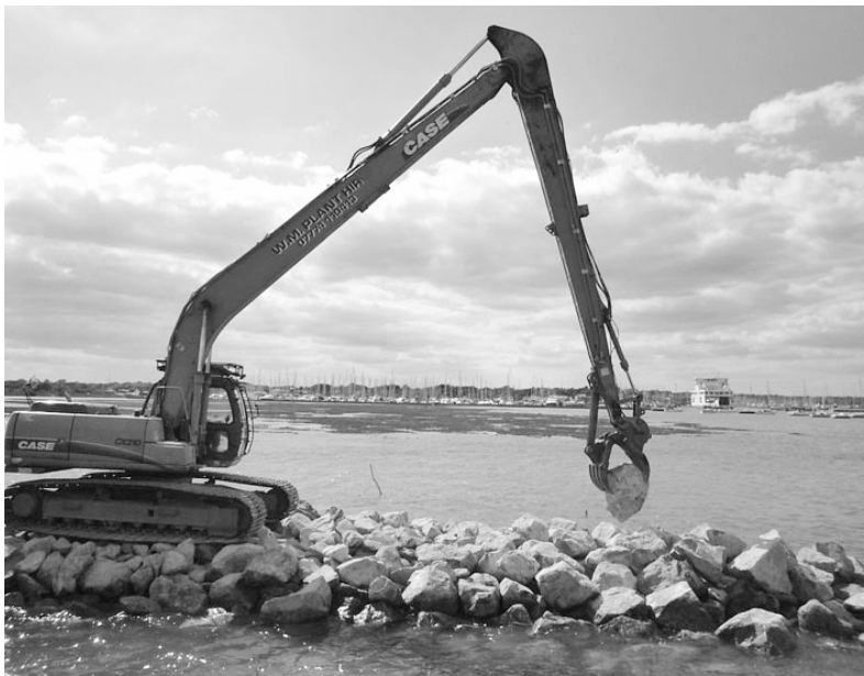
Slika 8.23 Hvatač za polaganje kamena „rip-rap“ na obalu
