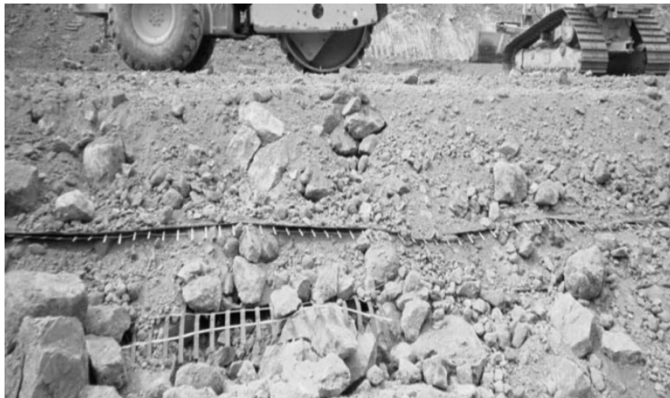
Slika 11.88 Armirani nasip bez lica
