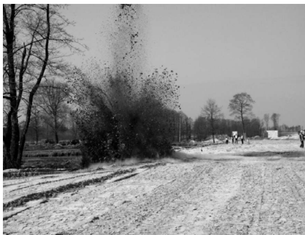
Slika 11.30 Učinak miniranja na površini ( http://www.polbud-pomorze.pl )
