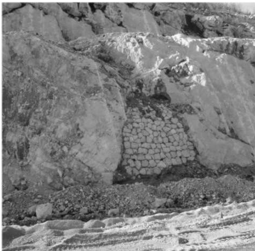
Slika 14.7 Zaštita pokosa u okršenoj stijeni na mjestu kaverne
