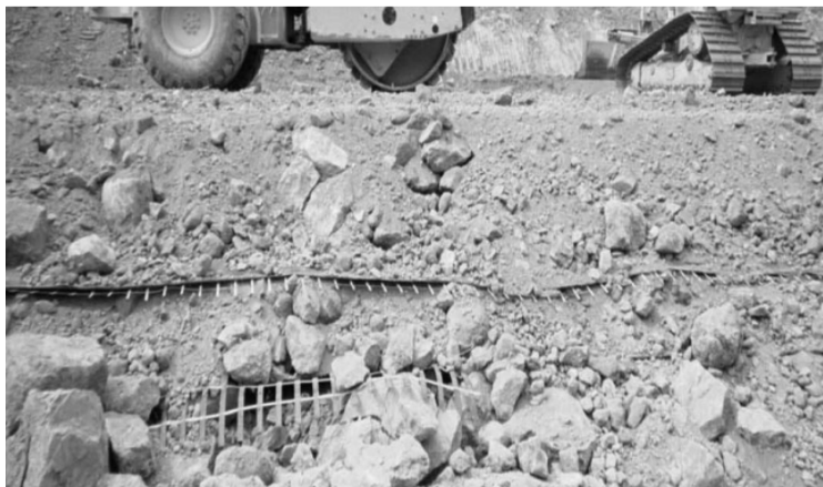
Slika 11.88 Armirani nasip bez lica
