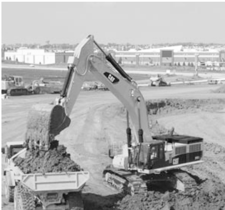
Slika 10.6 Utovar iskopanog tla u kamion jaružalom (bagerom)
