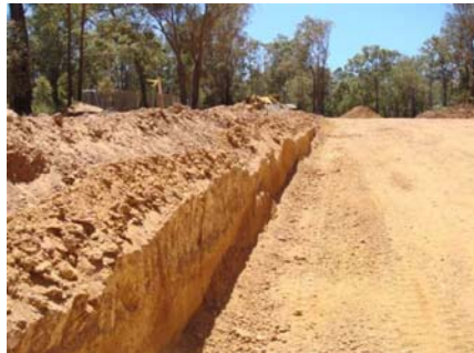
Slika 8.29 Iskop izveden glodalicom sa slike 8.28
