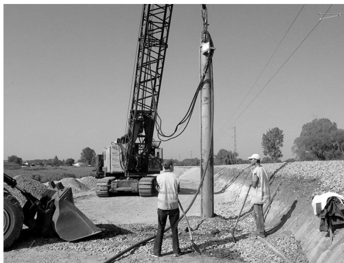
Slika 11.28 Uređaj za vibroflotaciju u radu
