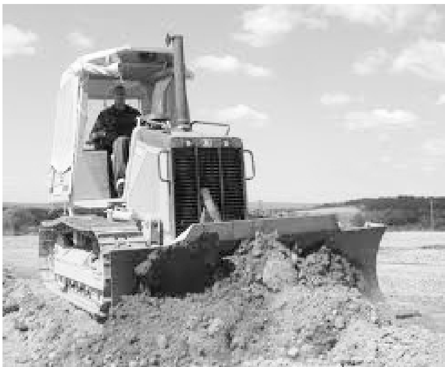
Slika 10.2 Buldozer za guranje iskopanog tla na manje udaljenosti
