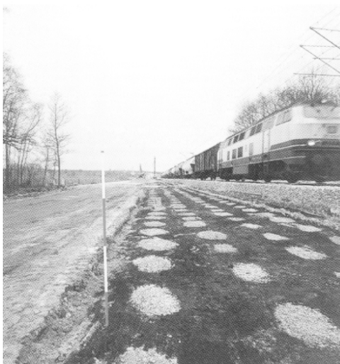
Slika 11.44 Šljunčani stupovi na površini tla
