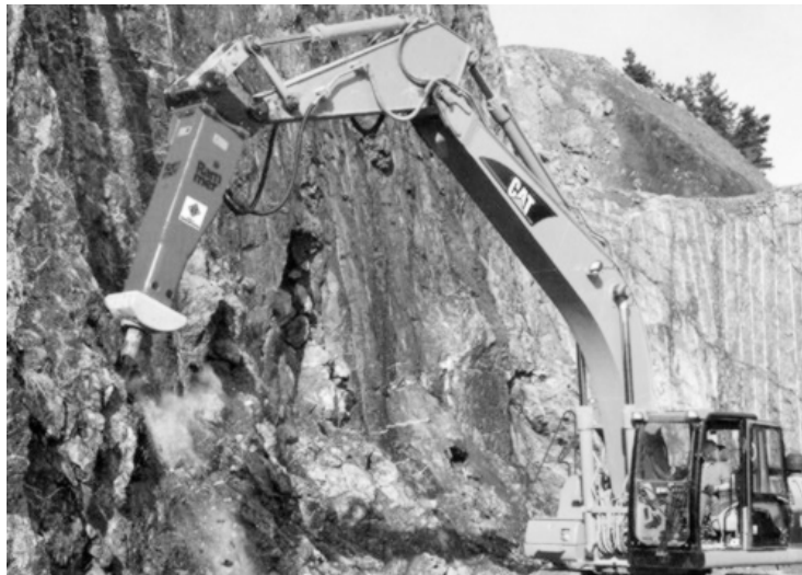
Slika 8.25 Iskop čvrste stijene montaberom
