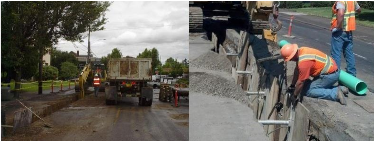
Slika 15. Iskop rova i postavljanje cijevi [10]
