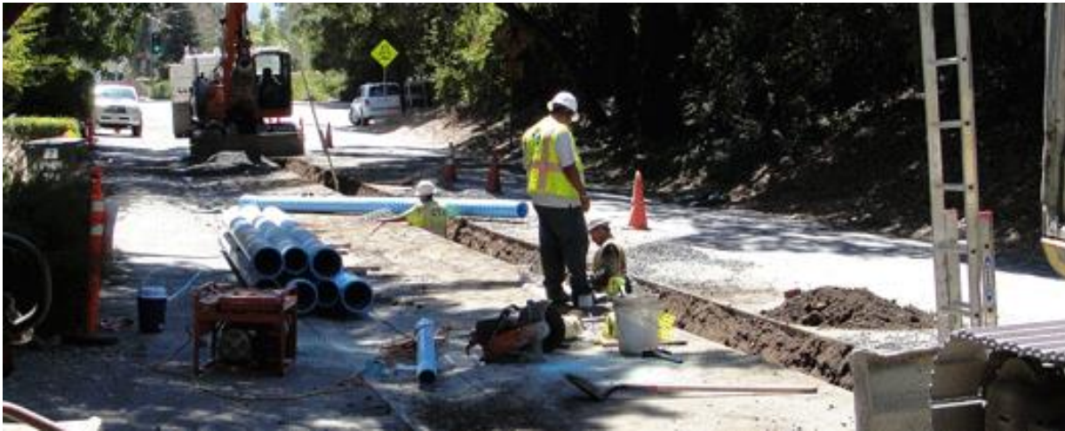
Slika 14. Oprema i materijali skladišteni na gradilištu [10]
