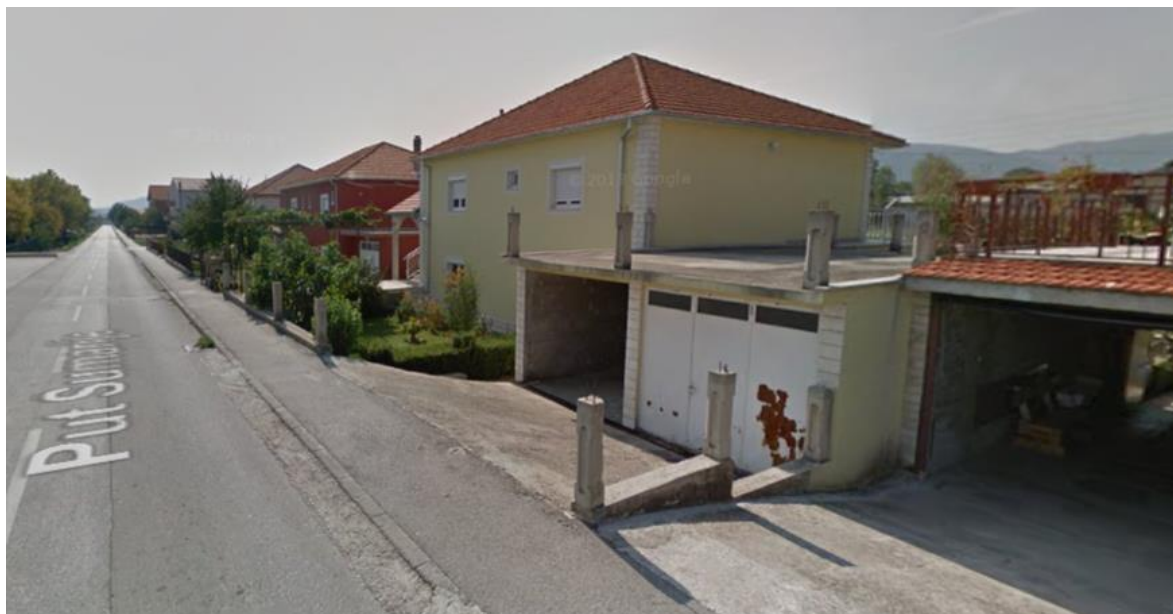
Slika 9. Kuće u odnosu na trup ceste u ulici „Put šumarije“
