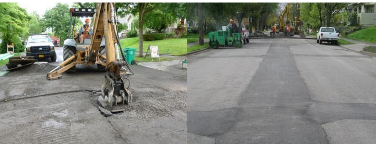
Slika 16. Zbijanje nasutog materijala i privremeni asfaltni sloj [10]
