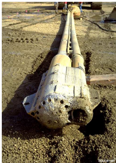
Slika 9.33 Sonda za vibroflotaciju sa cijevi kroz koju se dodaje šljunak u osvojeni prostor u koherentnim tlima, vide se otvori za vodu
