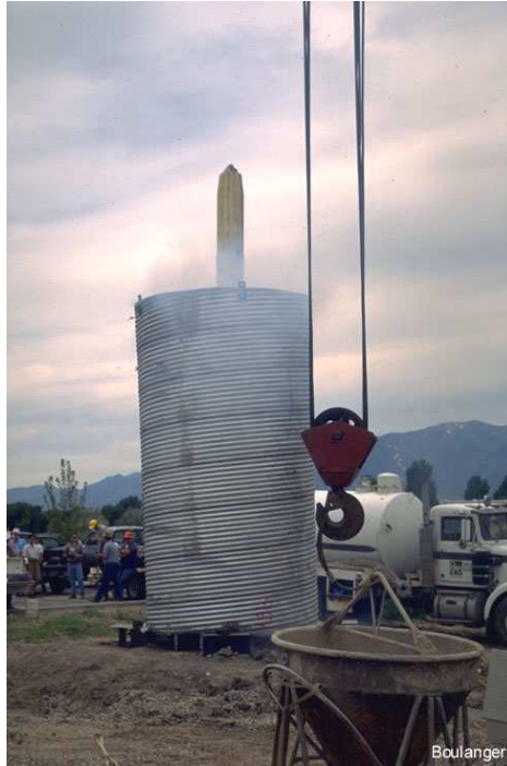
Slika 5.43 Uređaj sa šljunčanim punjenjem u trenutku eksplozije, na kopnu
