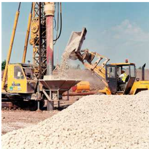
Slika 9.68 Stroj za izvedbu šljunčanih stupova u radu
