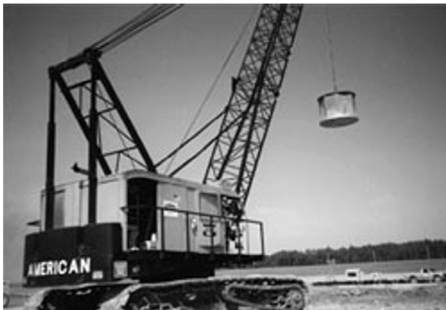
Slika 9.20 Oprema za dinamičko zbijanje tla
