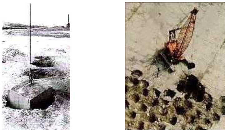
Slika 9.21 Učinak pada utega pri dinamičkoj stabilizaciji (WEB 6)
