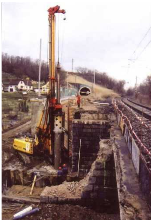
Slika 5.73 Iskop bušotine za pilot pod zaštitom cijevi (zaštitne kolone)
