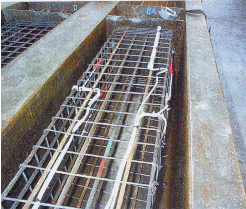
Slika 5.50 Ugradnja mjernih uređaja u armaturni koš predgotovljenog pilota u betonari
