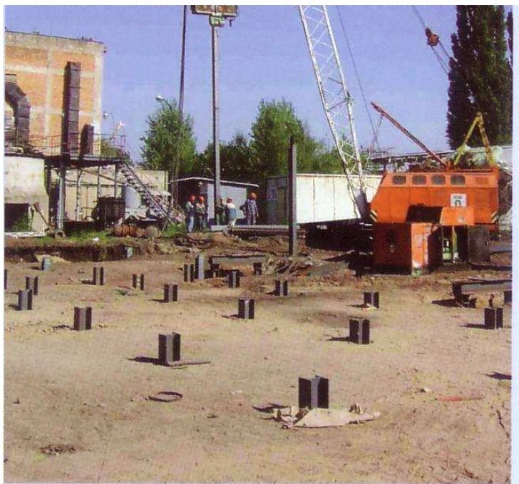
Slika 8.15 Glave mikropilota od čeličnih I profila, (u pozadini se vidi stroj za zabijanje pilota)
