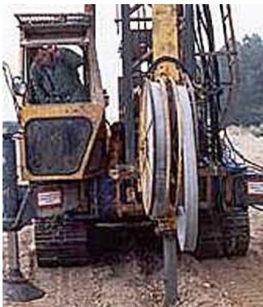
Slika 9.58 Uređaj za ugradnju savitljivih (mekih) drenova
