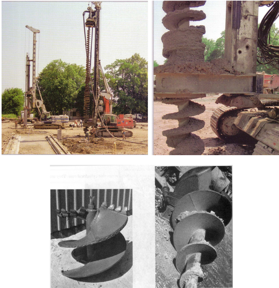
Slika 5.78 Stroj za iskop pilota svrdlom i detalj svrdla
