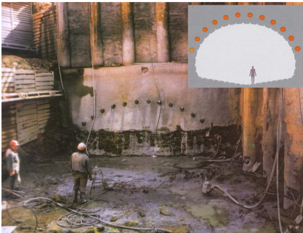
Slika 8.18 Ojačanje svoda prije iskopa tunela-Prag (Zakladani staveb 2003.)
