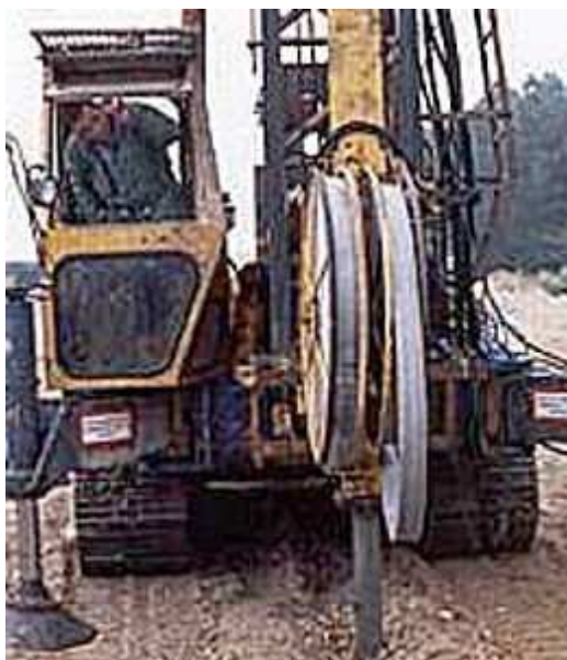
Slika 9.58 Uređaj za ugradnju savitljivih (mekih) drenova
