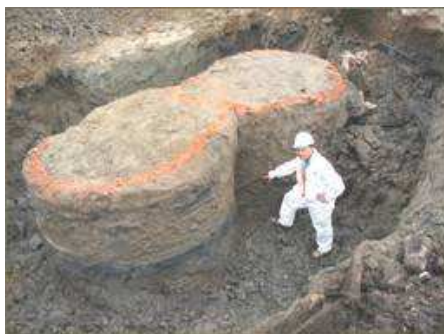
Slika 9.19 Otkopana tijela stabiliziranog tla
