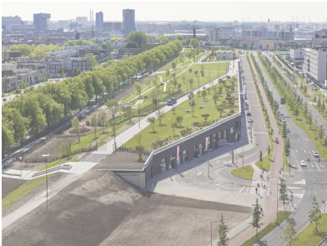
Dakpark, Rotterdam, Nizozemska, Buro Sant en Co
