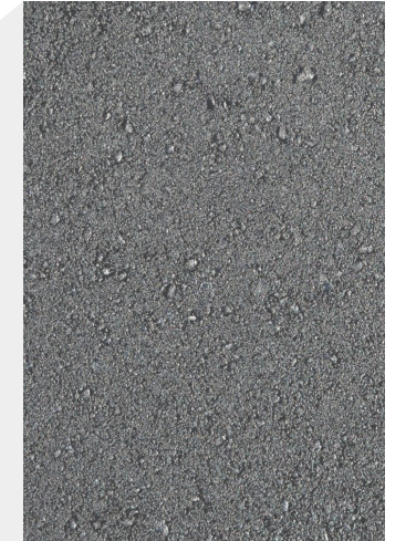
Asfalt, rampa podzemne garaže
