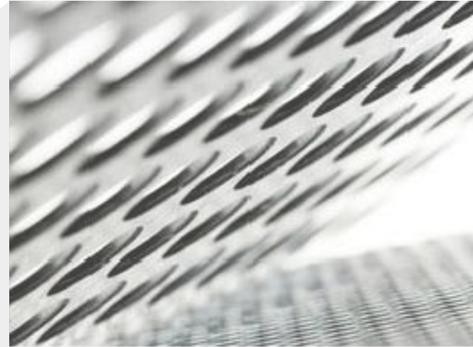
Perforirani fasadni lim, fasada prizemnog dijela objekta
