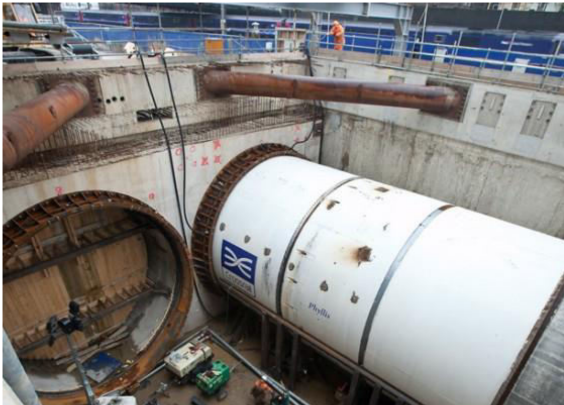
Slika 2.4.: Crossrail TBM (Tunnel Boring Machine) [9]
