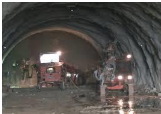
Slika 3. Primarna podgrada tunela [3]
