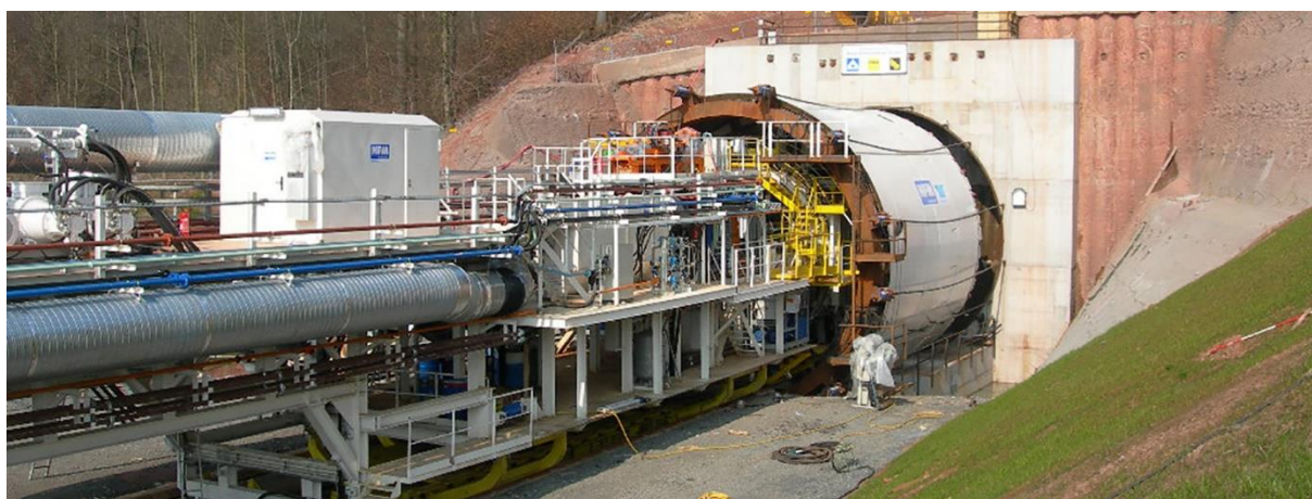
Slika 2. Prikaz probijanja tunela TBM-om [ ]
