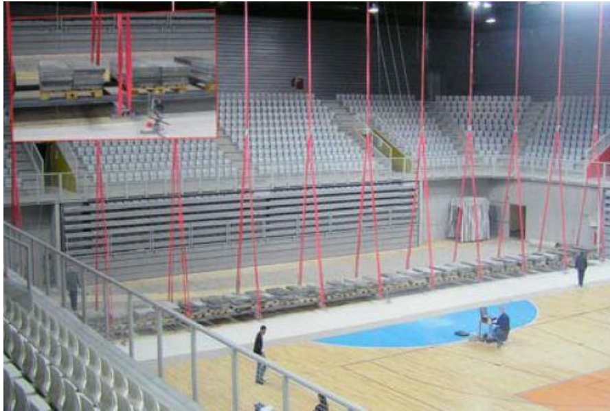
Fotografija 1.1: Statičko ispitivanje rešetkaste konstrukcije sportske dvorane
