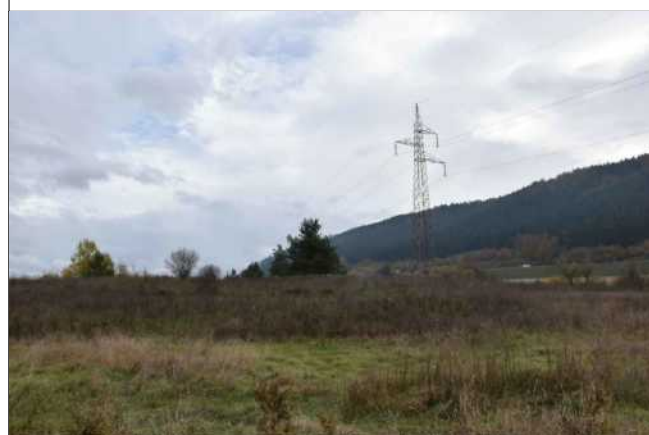
13. unutrašnjost obuhvata - dalekovod
