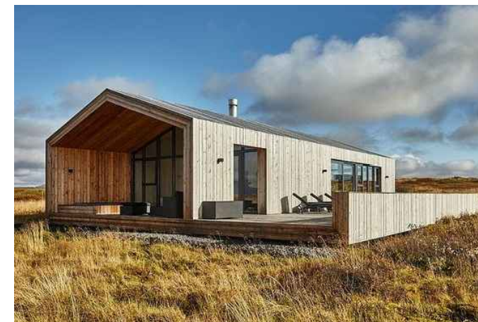
Dynjandisvegur Retreat / M2
