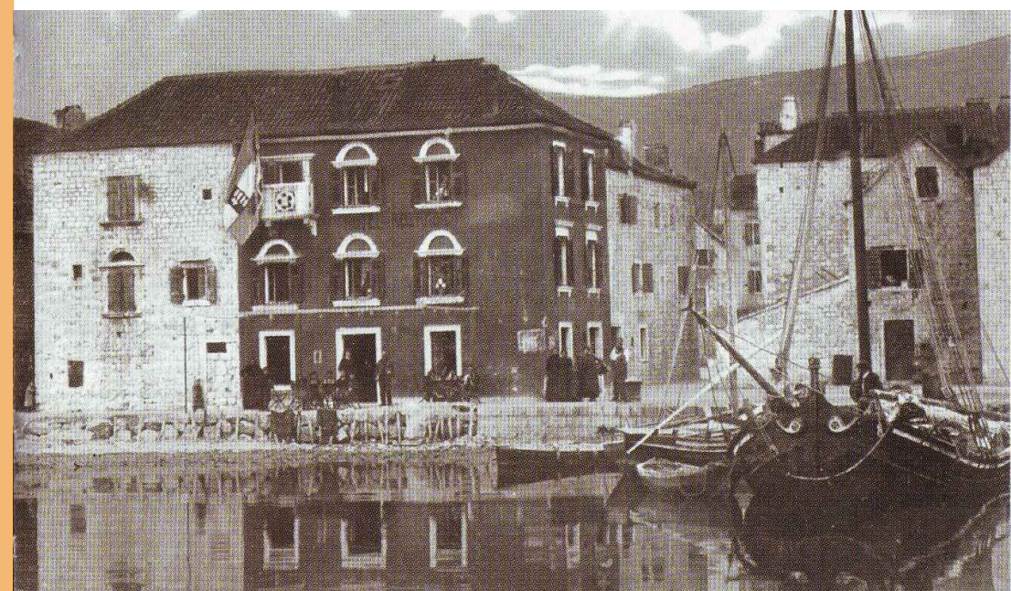
slika 1.10 | KAŠTEL KORIOLANA CIPIKA - JUŽNO PROČELJE, 20.ST
