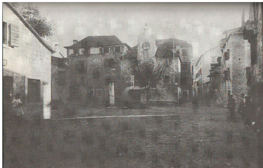
BRCE - POGLED PREMA ZAPADU
