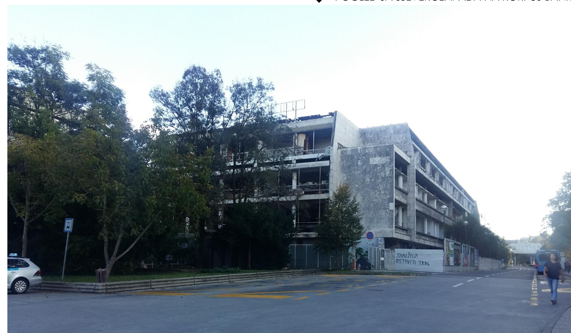
▼ POGLED SA SJEVEROZAPADA NA KORPUS BANKE
