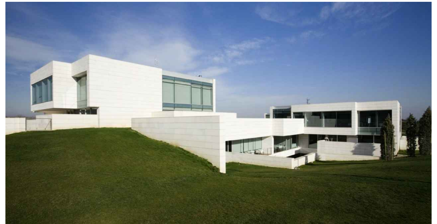
Finca Prats Hotel Golf & Spa / Pàmpol's Arquitecte SLP
