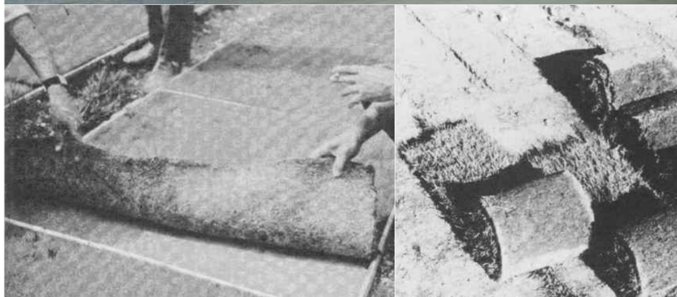
sl.13.,lijevo, Zaštita pokosa primjenom busenja
