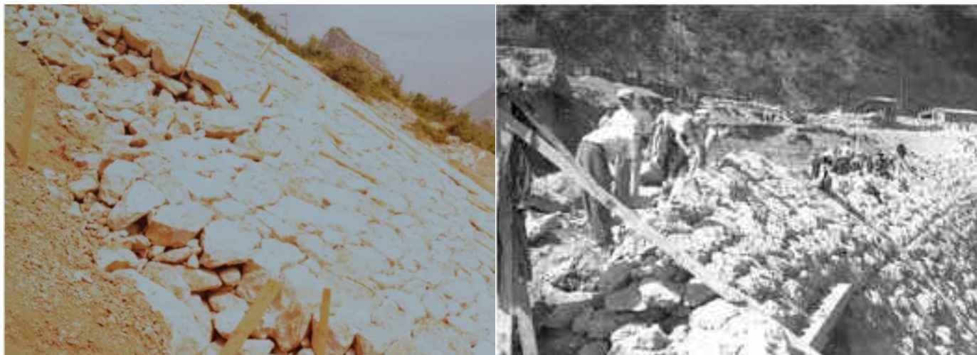
sl.19., sl.20. Izvedba slagane kamene obloge
