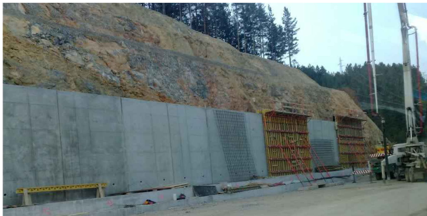
sl.12., Podupiranje pokosa potpornim zidom
