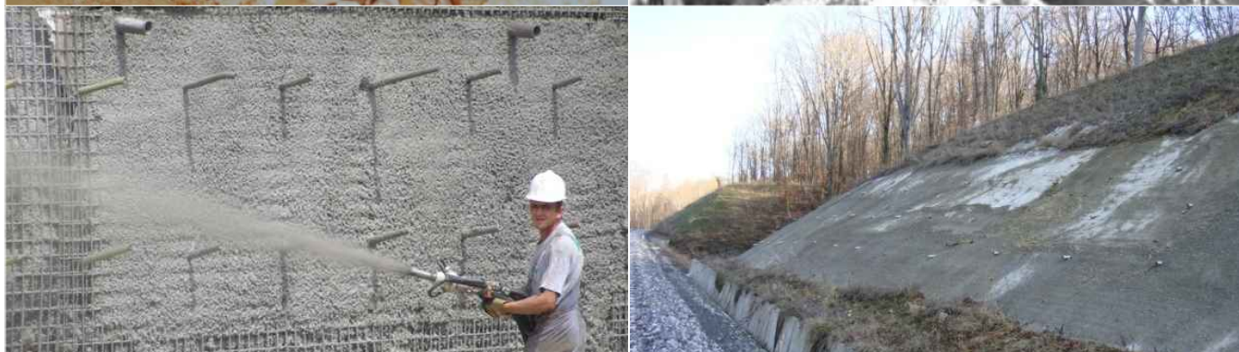
sl. 21., sl. 22. Zaštita pokosa torkretiranjem (mlazni beton)
