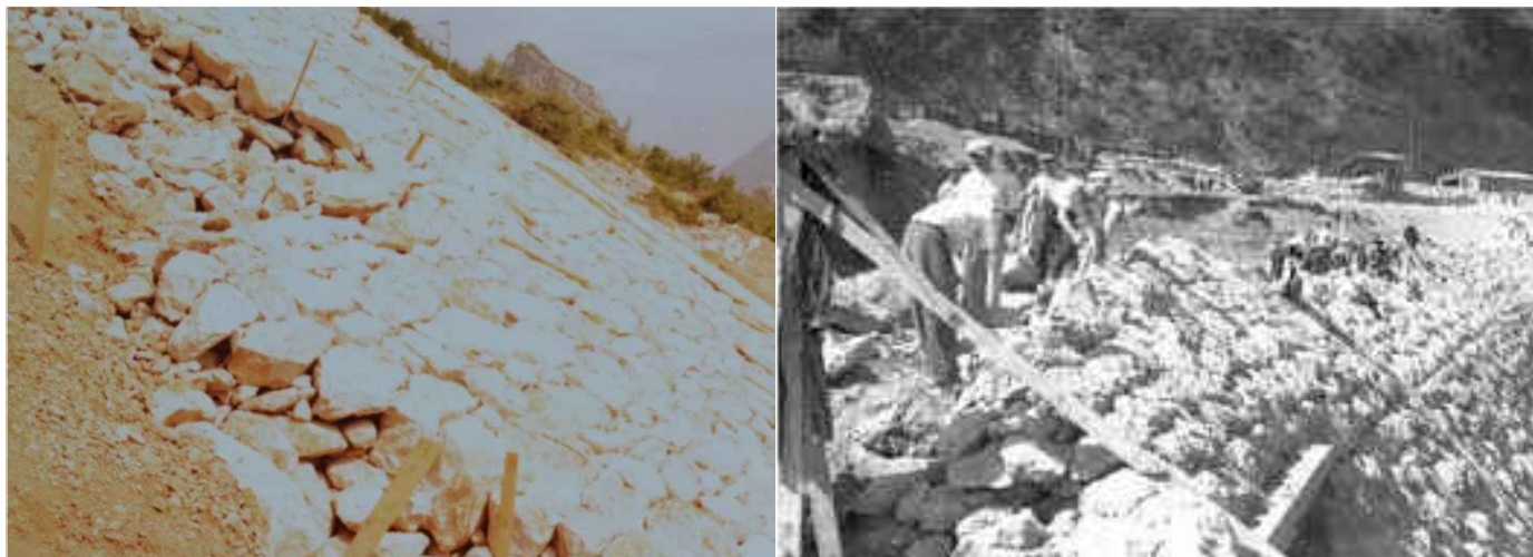
sl.19., sl.20. Izvedba slagane kamene obloge
