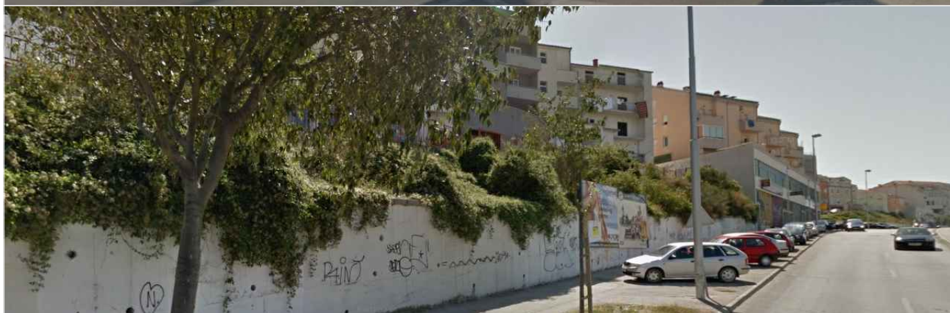
sl. 24., potporni zid na Visokoj, Split
