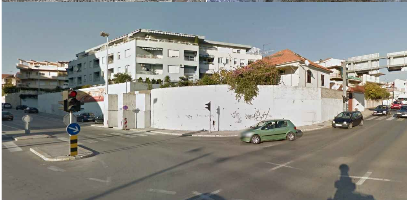
sl. 23., potporni zid na Visokoj, Split
