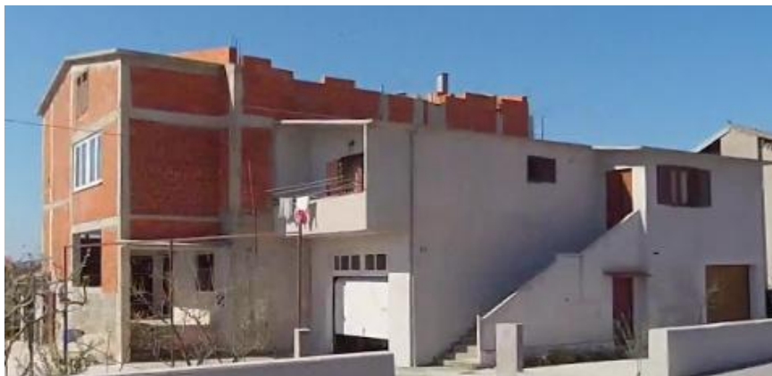
Slika 46. Izvedeno stanje predmetne građevine. (Preuzeto: https://www.google.com/maps/ )
