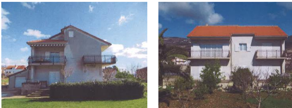
Slika 61. Izvedeno stanje predmetne građevine. (Preuzeto: Fotodokumentacija danim arhitektonskim snimkom)
