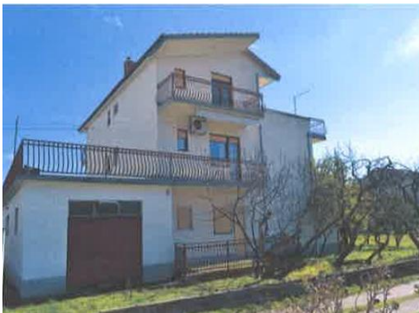
Slika 42. Izvedeno stanje predmetne građevine. (Preuzeto: Fotodokumentacija danim arhitektonskim snimkom)
