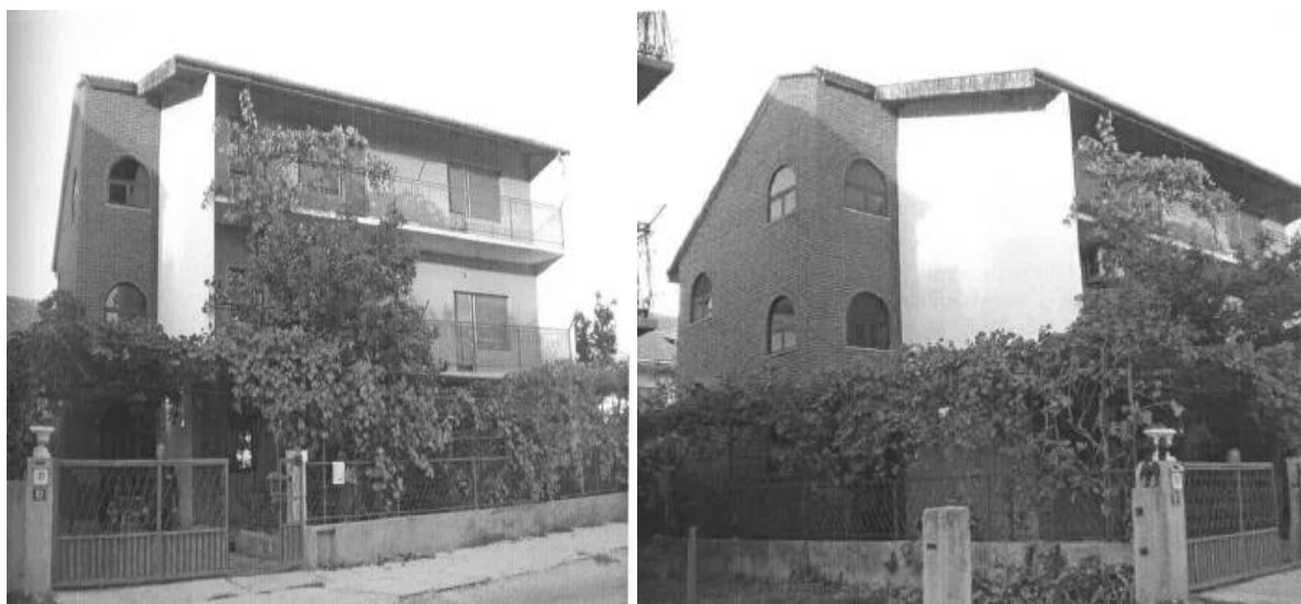
Slika 58. Izvedeno stanje predmetne građevine. (Preuzeto: Fotodokumentacija danim arhitektonskim snimkom)
