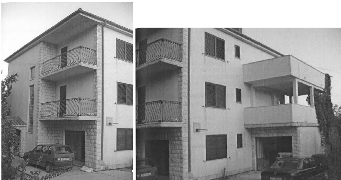
Slika 52. Izvedeno stanje predmetne građevine. (Preuzeto: Fotodokumentacija danim arhitektonskim snimkom)
