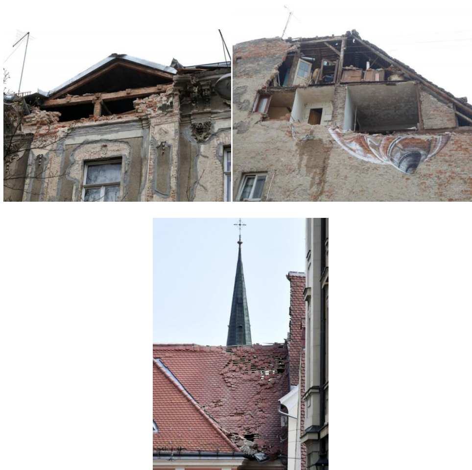
Slika 1. Utjecaj potresnih djelovanja na konstrukciju.
