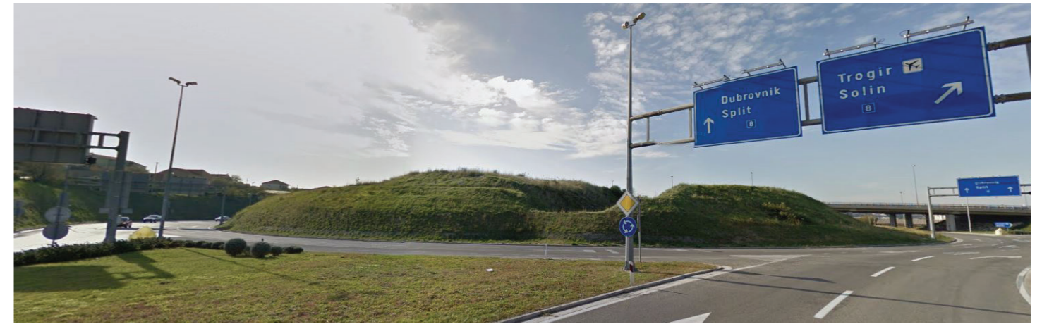
Pogled na lokaciju_priklučivanje ceste D1 na D8
