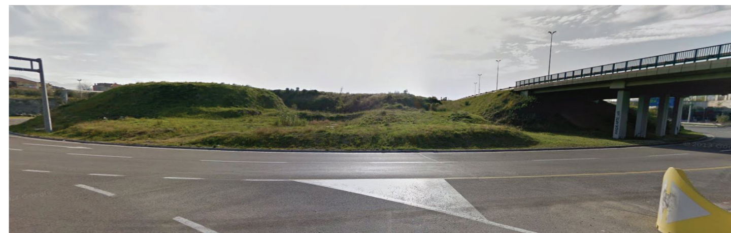
Pogled na lokaciju_sa priključkom na trgovački centar
