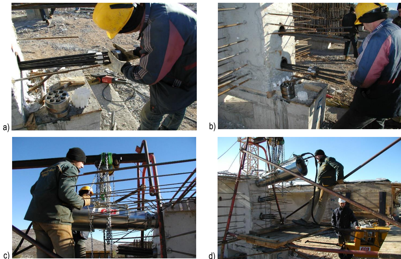
Slika 7.15 – Izvođenje naknadnog prednapinjanja nosača nekog mosta - prednapinjanje
