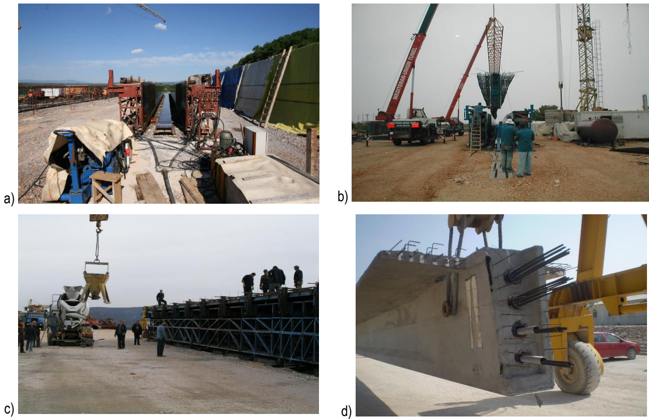
Slika 7.14 – Izvođenje naknadnog prednapinjanja nosača nekog mosta – betoniranje nosača
