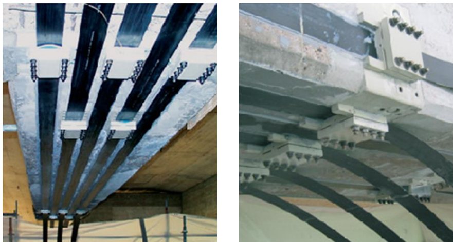
Slika 7.47 – Obnova mosta prednapetim karbonskim trakama
