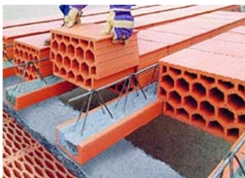
Slika 6.45 – Sustav Fert – Postavljanje ispuna na gredice
