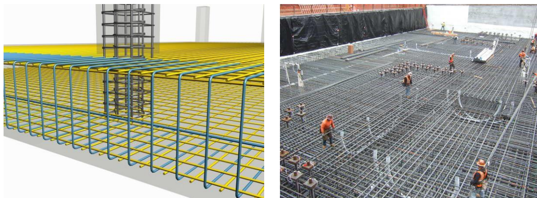
Slika 6.122 – Neki primjeri armiranja punih temeljnih ploča [18]
