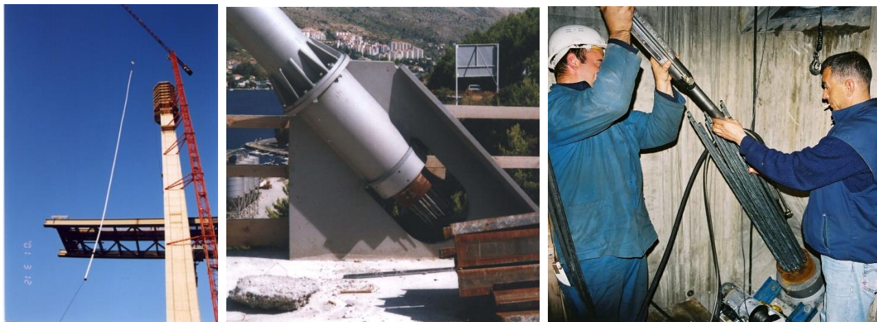
Slika 7.42 – Most Dubrovnik – Izvedba vješaljki: podizanje vješaljke, učvršćenje i prednapinjanje
