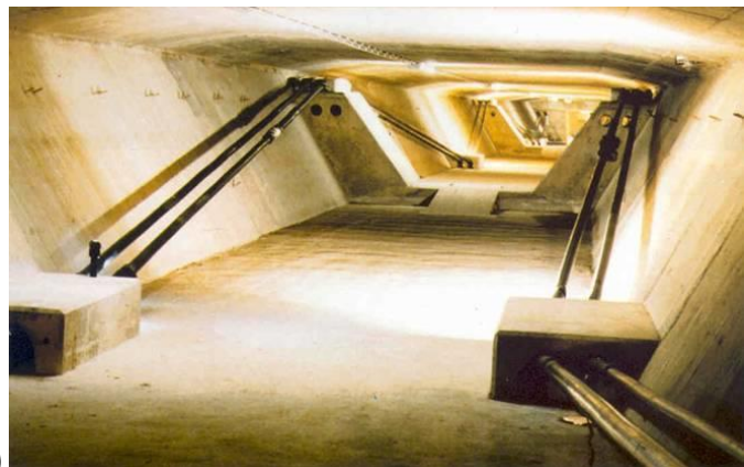
Slika 7.9 – Vanjsko prednapinjanje [20] & [21]
