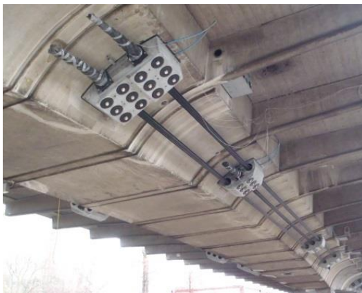
Slika 7.9 – Vanjsko prednapinjanje [20] & [21]
