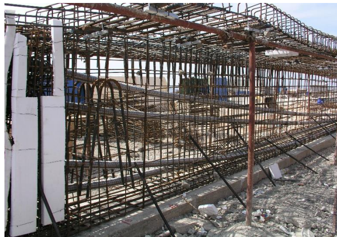
Slika 7.8 – Unutrašnje prednapinjanje
