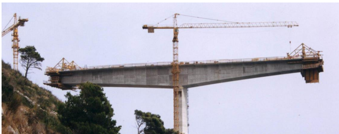
Slika 7.43 – Most Dubrovnik – Položaj natega pri prednapinjanju mosta Dubrovnik
