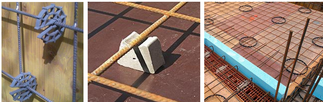
Slika 2.26 – Neki primjeri ugradnje distancera
