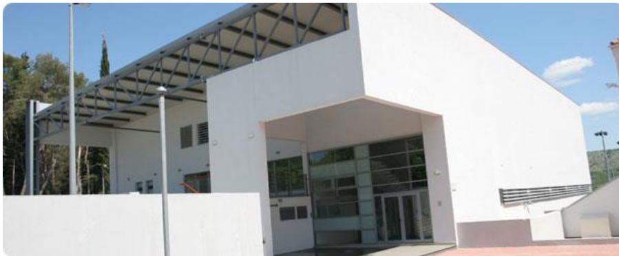
Slika 6.94 – Školska sportska dvorana Dugopolje – konzolni zidni nosač
