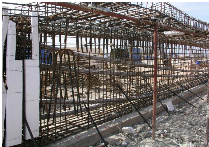
Slika 7.8 – Unutrašnje prednapinjanje
