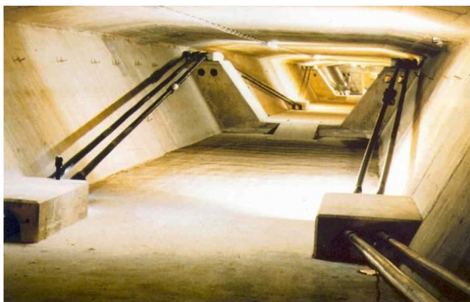
Slika 7.9 – Vanjsko prednapinjanje [20] & [21]
