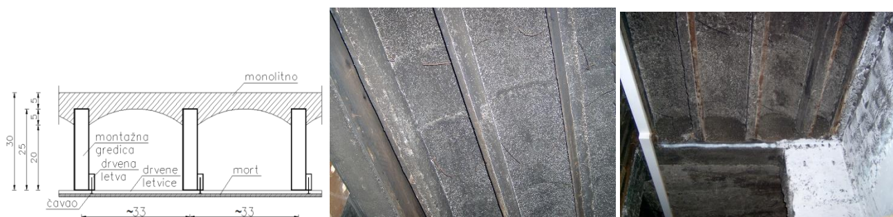
Slika 6.37 – Sustav Isteg, poprečni presjek i izgled
