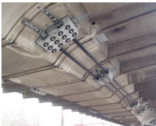
Slika 7.9 – Vanjsko prednapinjanje [20] & [21]
