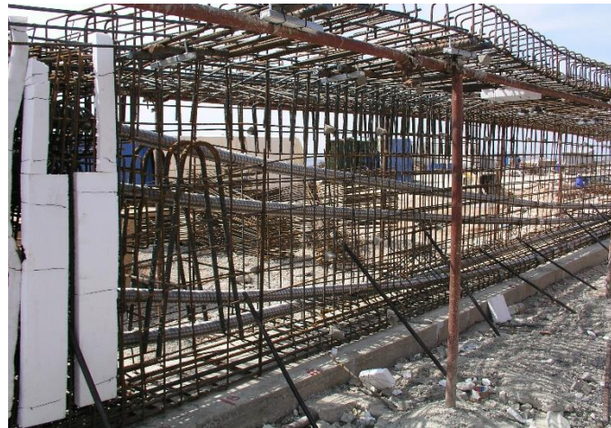
Slika 7.8 – Unutrašnje prednapinjanje
