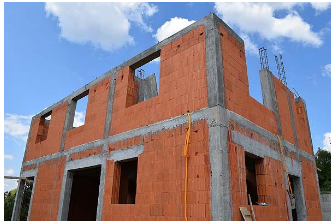
Slika 6.64 – Nadvoj u zidanom zidu
