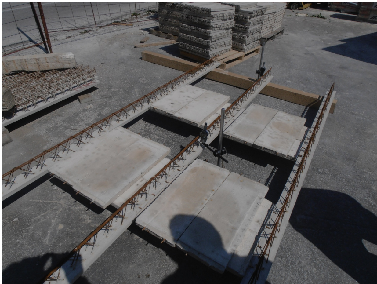
Foto 4.7: Provedba ispitivanja ( II. faza opterećenja)
