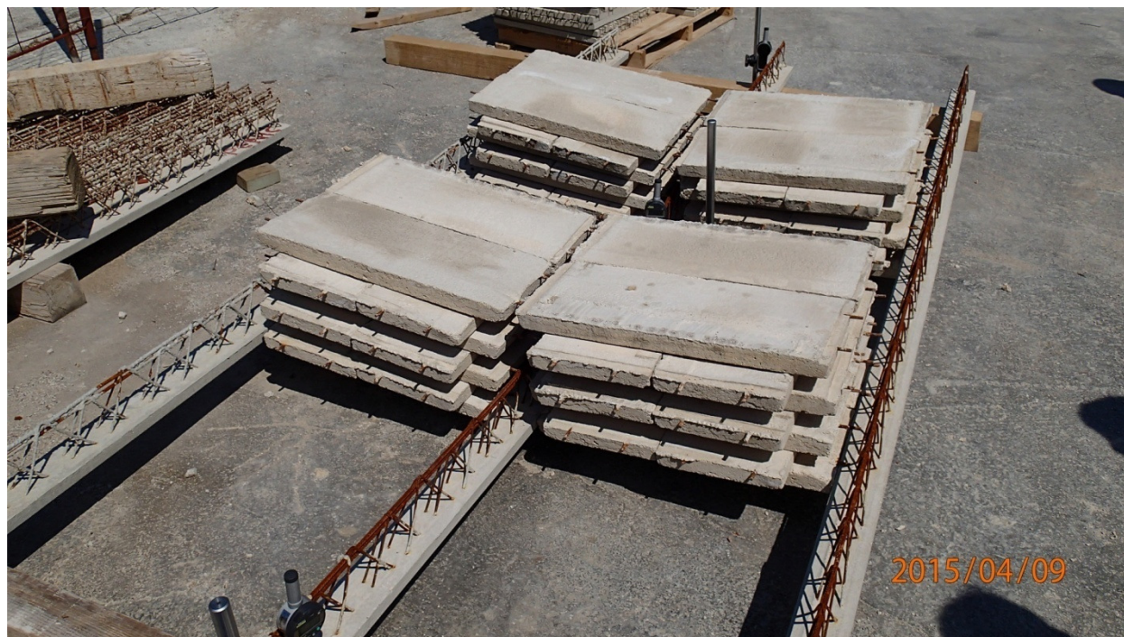
Foto 4.9: Provedba ispitivanja ( VII. faza opterećenja) – lomno opterećenje
