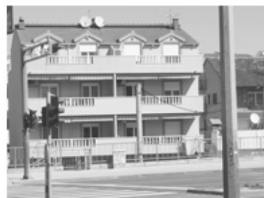
VIŠESTAMBENA ZGRADA na Vukovarskoj ulici
