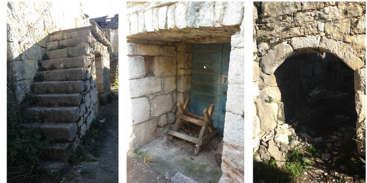
Grafički prilog 39. Arhitektonski elementi u Mužinićima - balatura, vrata s kamenim nadvojem, lučni nadvoj kao ulaz u dvorište / fotografije autora analize
