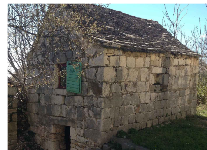
Grafički prilog 51. Minimalni otvori na kamenoj kući / fotografija autora analize
