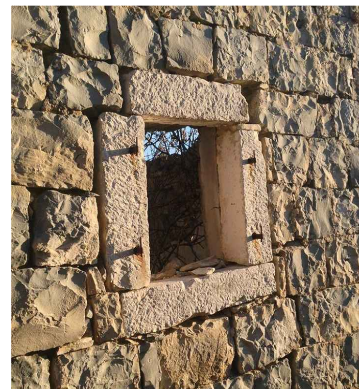
Grafički prilog 59. Prozor sa šķurama, Kostanje; nepravilno klesani nadvoji nad prozorima, Gata / fotografije autora analize
