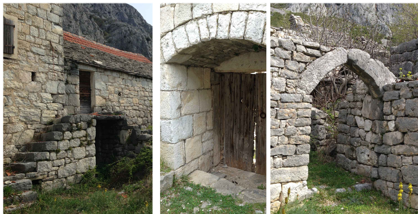
Grafički prilog 28. Balatura, kameni nadvoji iznad vrata i ulaza u dvor / fotografije autora analize
