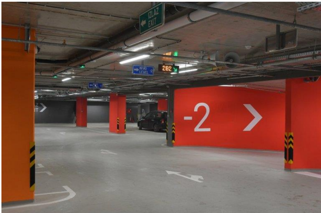
Slika 25 Podzemna garaža sa oznakama razine te znakovima koji vode prema izlazu
