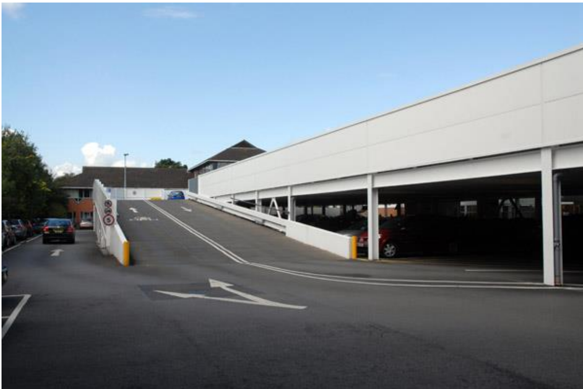
Slika 14 Rampa u pravcu kao spoj između dvije etaže garaže
