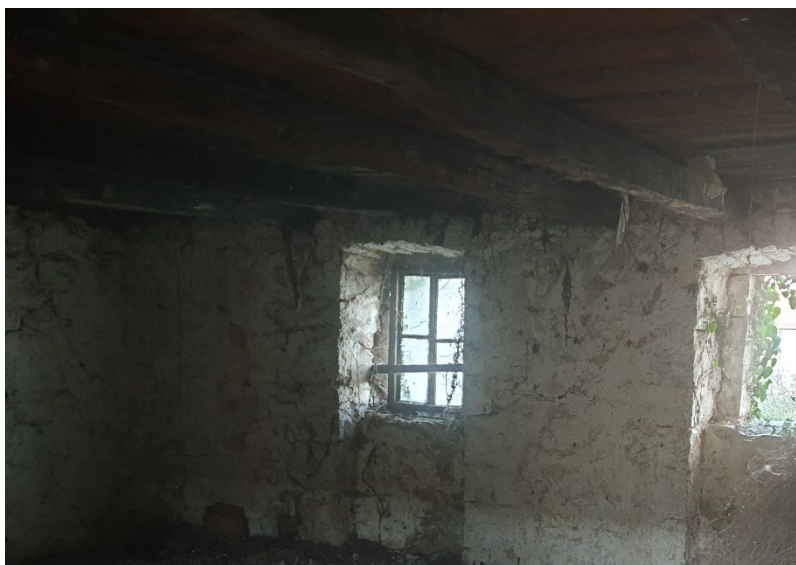
Slika br.3 Unutarnji zidovi i međukatna konstrukcija
