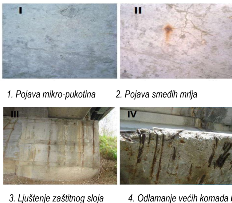
Slika 2.1 Stupnjevi degradacije
