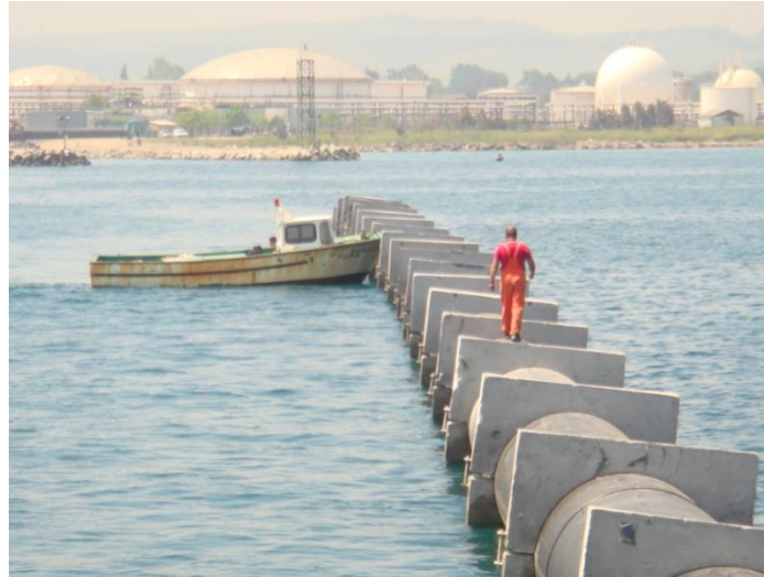
Slika 15. Pridržanje cjevovoda u moru
