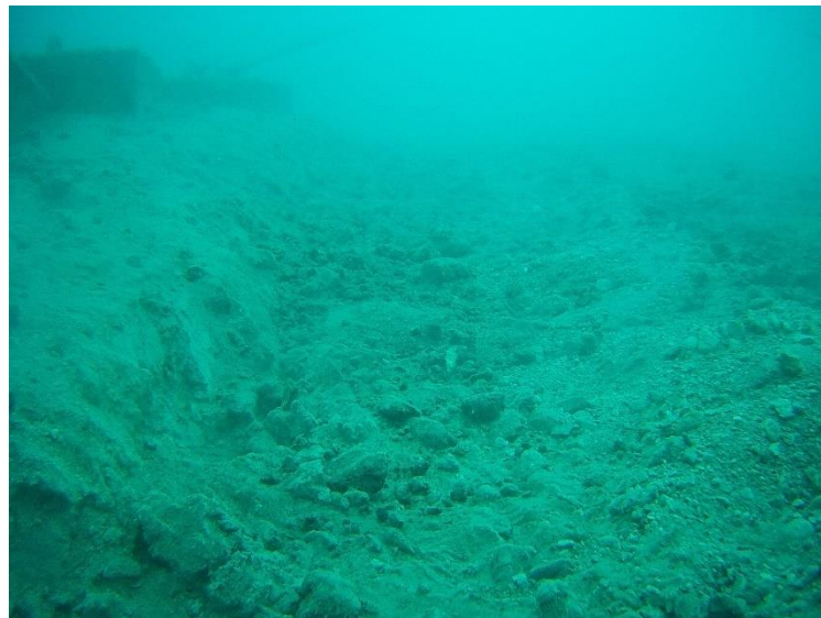
Slika 29. Prikaz konačnog stanja nakon zatrpavanja
