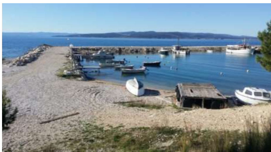
Slika 4. Prikaz postojećeg stanja
