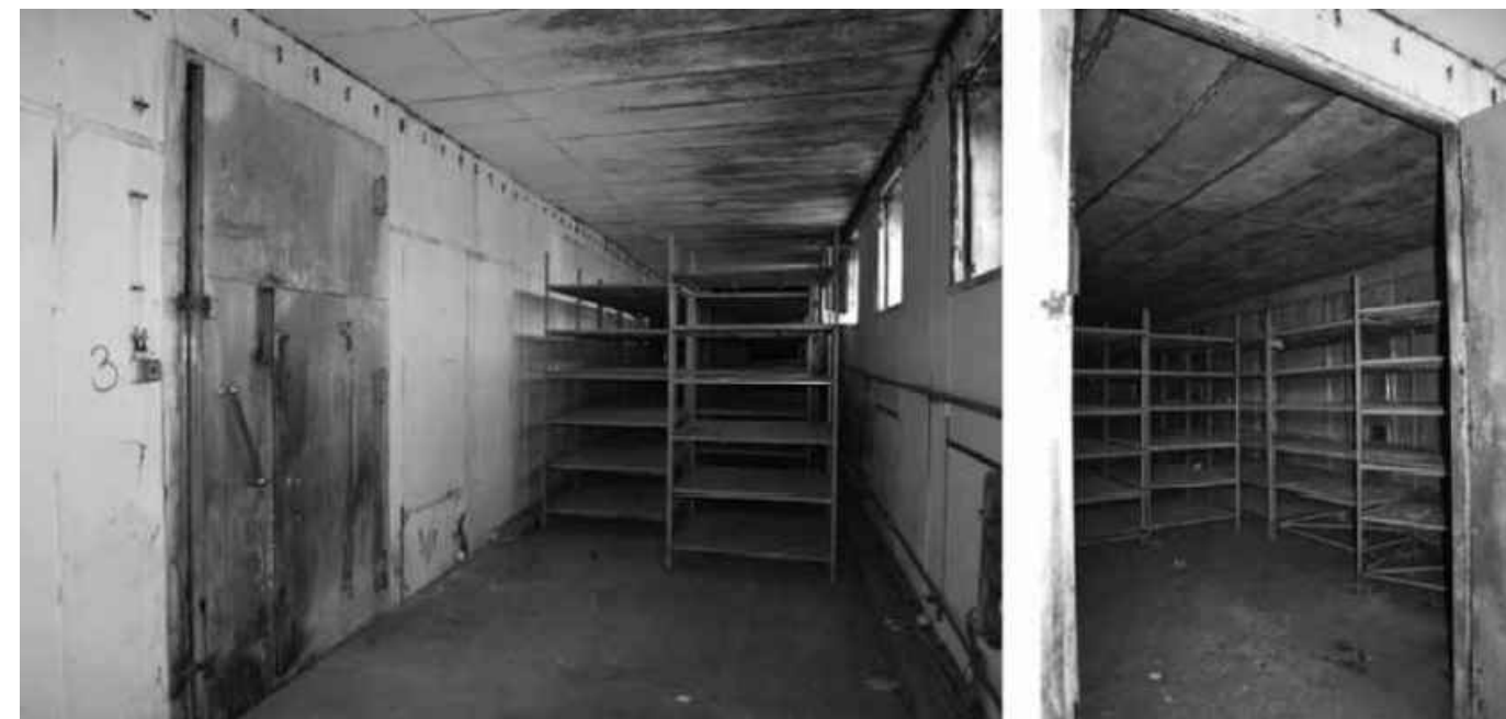
Hodnik ispred ferm komore stanice Grude/unutrašnjost komore
