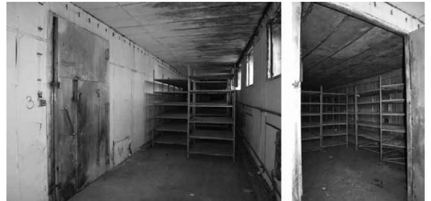
Hodnik ispred ferm komore stanice Grude/unutrašnjost komore
