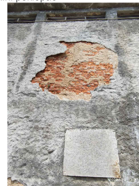
③ Konstrukcija od opeke prekrivena žbukom
