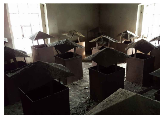
① Cijevi za odvođenje zraka prilikom sušenja slada u sušari
