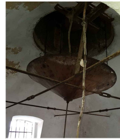
① Metalni poklopac za isparivač
