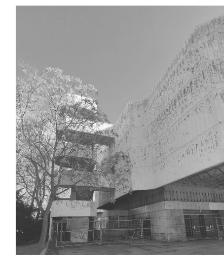
_vanjsko stubište za krovnu terasu
