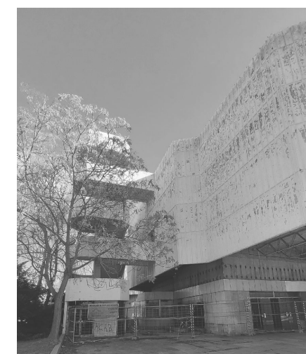
_vanjsko stubište za krovnu terasu
