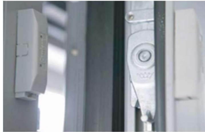
mikroprekidač na prozoru, izvor: EIHP
