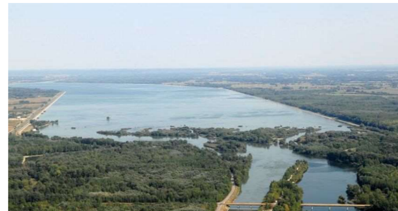
Najveće umjetno jezero u Hrvatskoj je Dubravsko jezero koje je izgrađeno na rijeci Dravi za potrebe hidroelektrane Dubrava.
