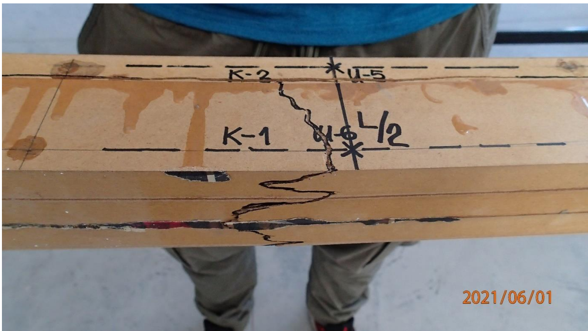
Slika 67: Pukotine na vanjskom licu poprečnog presjeka nosača
