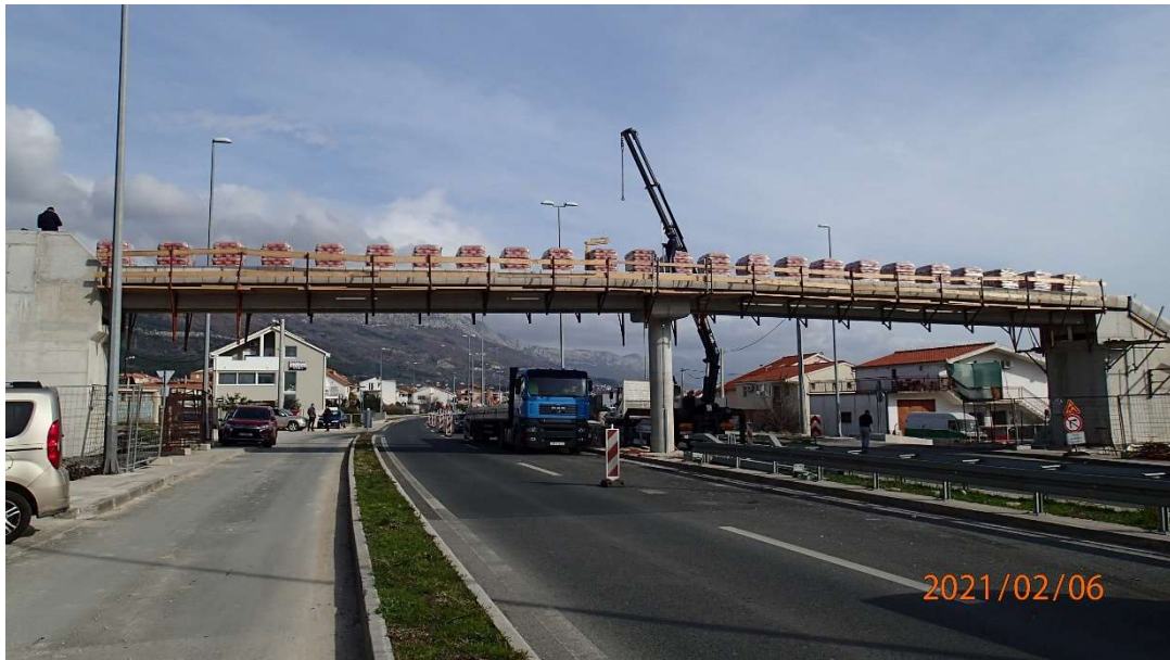
Slika 4.10. Faza 5 – opterećenje na oba raspona
