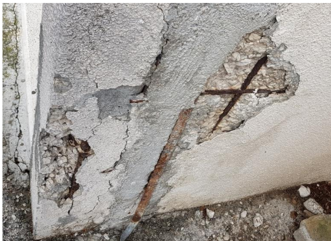
Slika 8. Problemi uslijed nedostatka zaštitnog sloja
