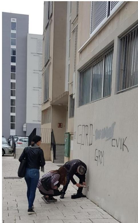
*Slika 9. Mjerenje kvalitete betona pomoću sklerometra*
