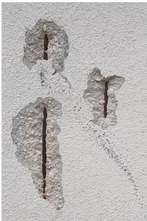
Slika 7. Ogoljena armatura na konstrukciji
