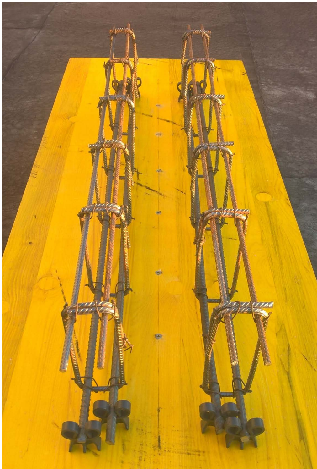
Fotografija 2.4: Armatura greda G1 i G2
