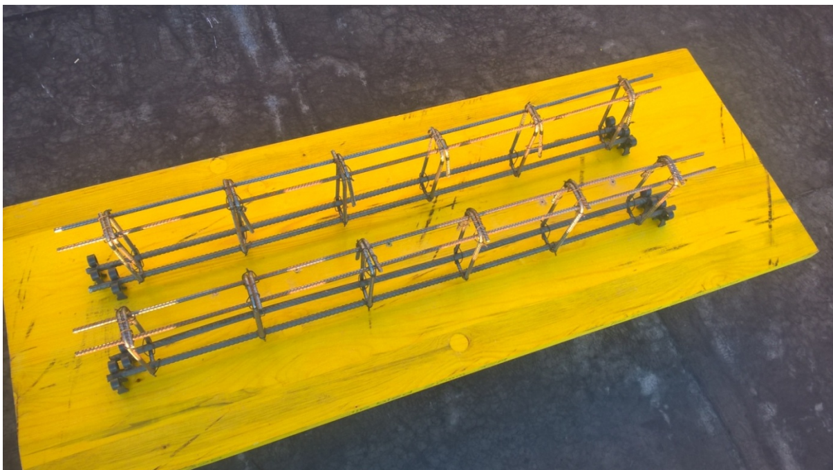
Fotografija 2.3: Armatura greda G1 i G2
