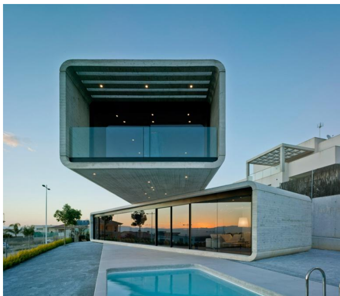
Slika 3: Privatna kuća sa konzolom dužine 10m, regija Murcia, Španjolska [9]
