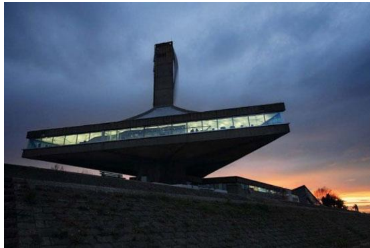
Slika 2: Zgrada Dunavski cvijet sa konzolom dužine 12m, Beograd, Srbija [9]
