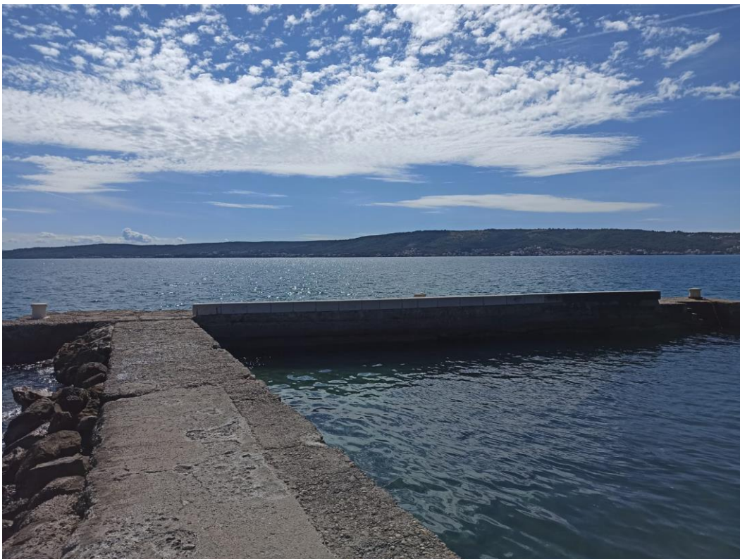
Slika 1.4 Prilaz južnom lukobranu
