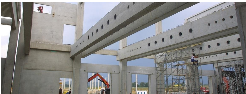
Slika 8. Montažni betonski elementi
