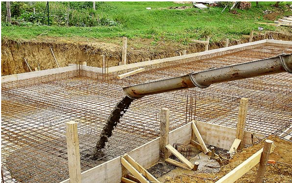
Slika 2. Prikaz procesa betoniranja temelja
