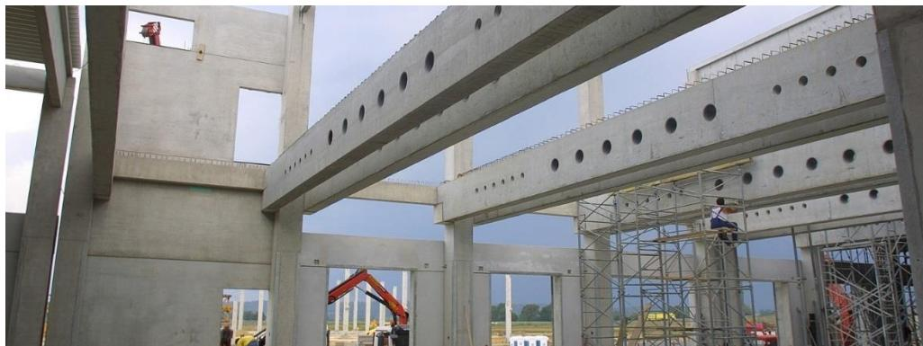
Slika 8. Montažni betonski elementi
