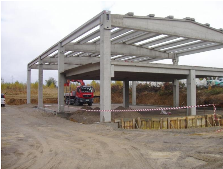
Slika 7. Montažna betonska gradnja
