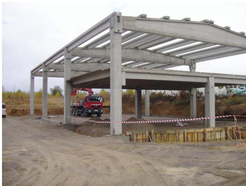
Slika 7. Montažna betonska gradnja
