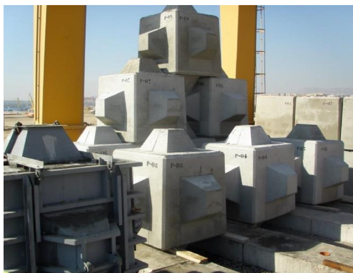
Slika 4.7.3. Detalj Cubipod elementa
