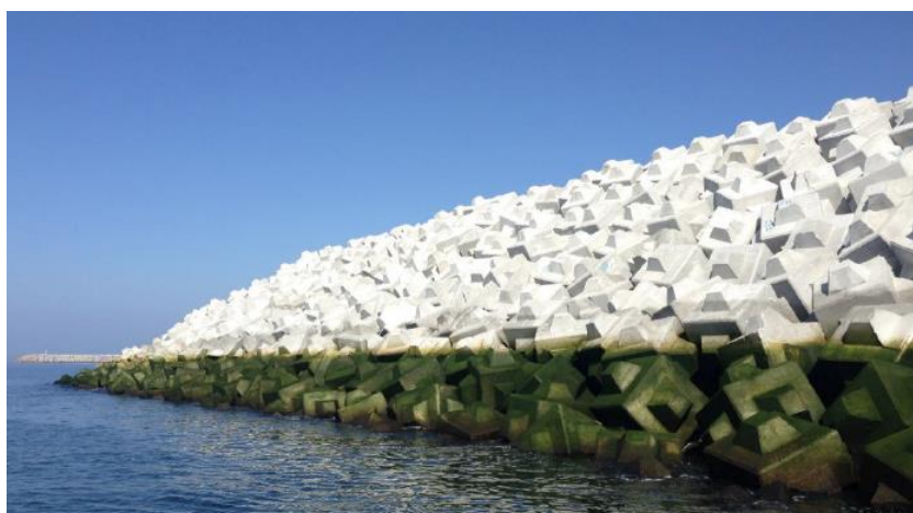
Slika 4.7.2. Pokos trupa lukobrana s Cubipod primarnom zaštitom
