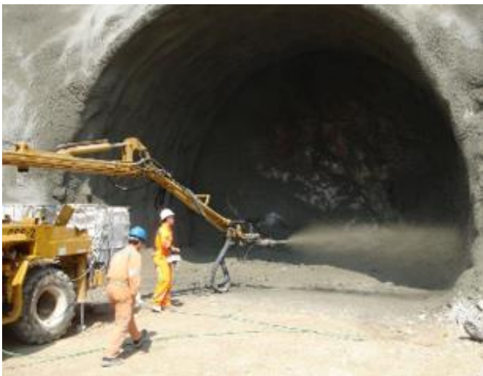
Slika 3. Primjena mikroarmiranog betona u izgradnji tunela [6]
