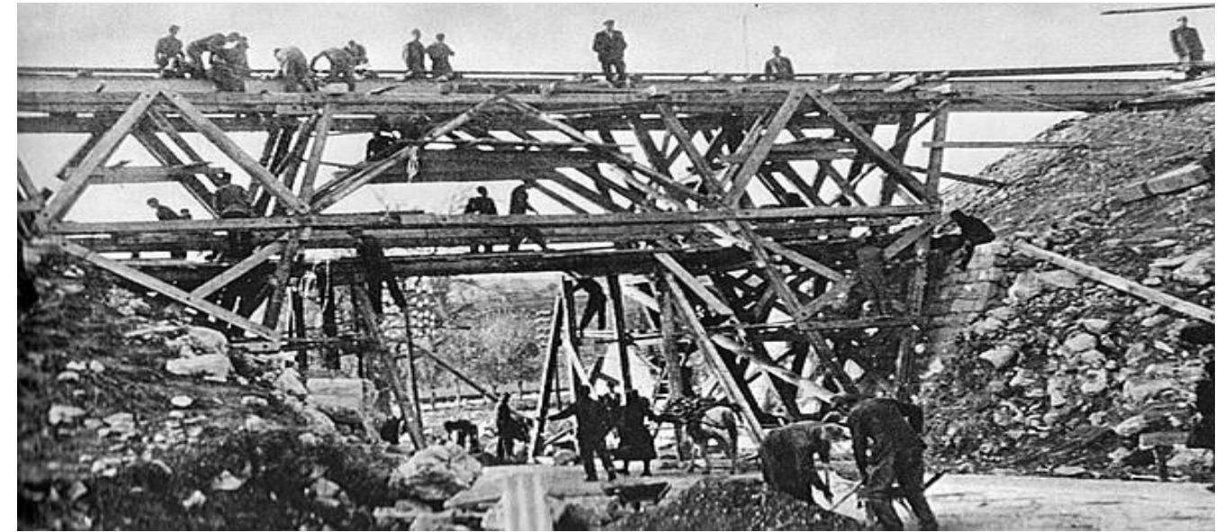
Obnavljanje željezničkog mosta Split-Sinj
