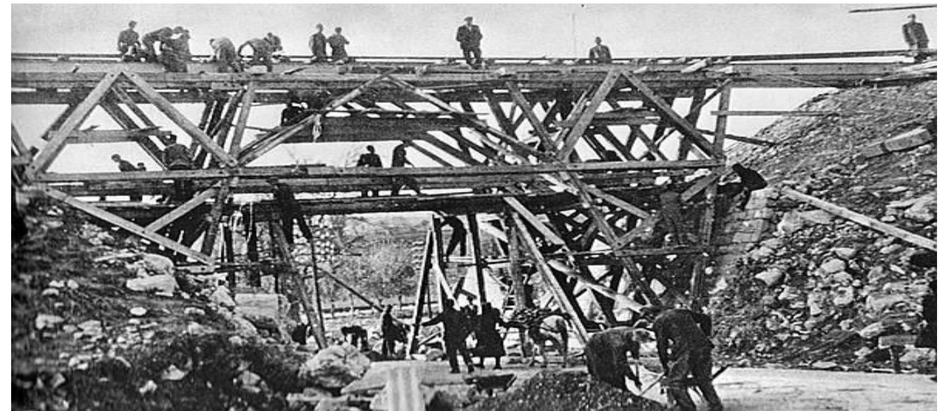
Obnavljanje željezničkog mosta Split-Sinj
