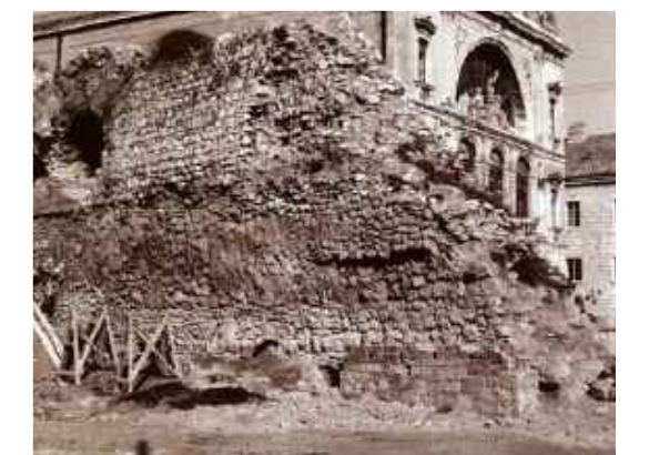
_17 Priuli - unutarnje lice zidanog dijela
