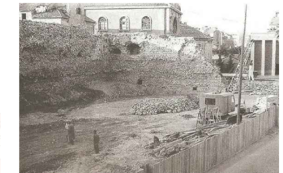
_16 Radovi prilikom probijanja sjevernog zida bastiona, 1951. g.
