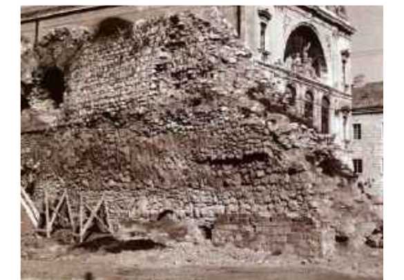
_17 Priuli - unutarnje lice zidanog dijela
