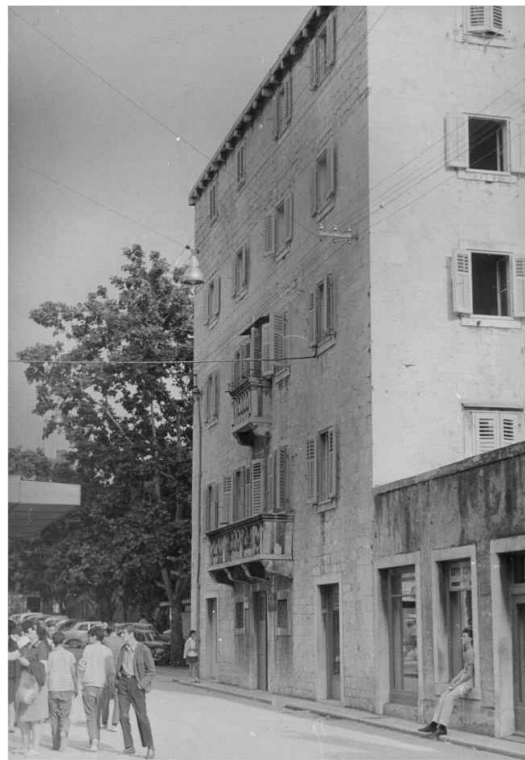
...32 Zgrada glazbene škole u Ulici kralja Tomislava
