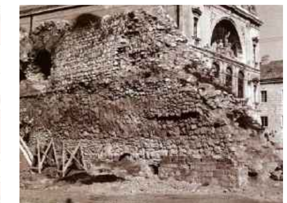
_17 Priuli - unutarnje lice zidanog dijela
