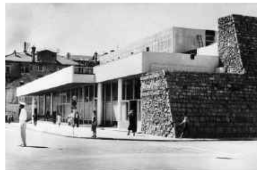
_25 Izvedeni objekt - spoj s bedemom
