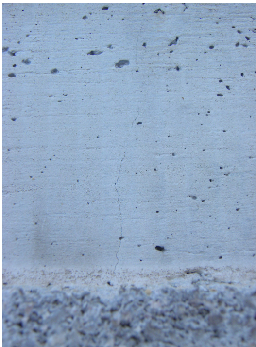
Fotografija 6.12. Prikaz vertikalne pukotine po dužini ploče
