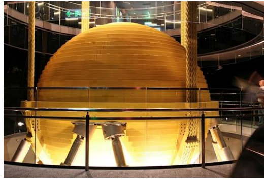
Slika 2.7.2.3 TMD sustav prigušenja – Taipei 101
